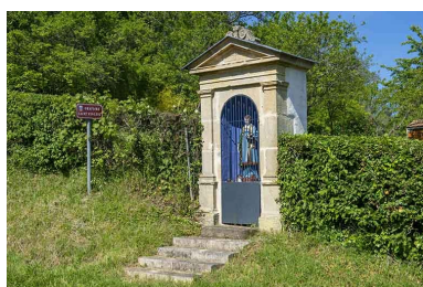
Oratoire saint Vincent. Phot. Jérôme Mongreville IVR43_20217000314NUC4A
