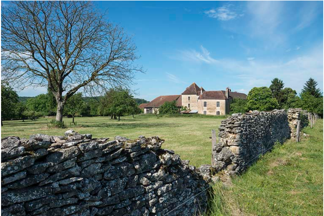
La façade orientale de la maison forte.
