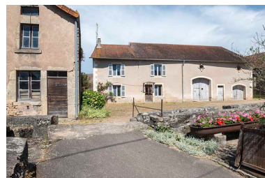
Ferme située rue de la Prairie. Phot. Jérôme Mongreville IVR43_20177000760NUC4A
