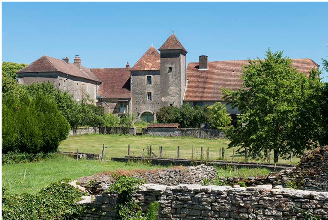
Vue générale de la maison forte.
