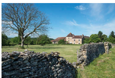
La façade orientale de la maison forte.
