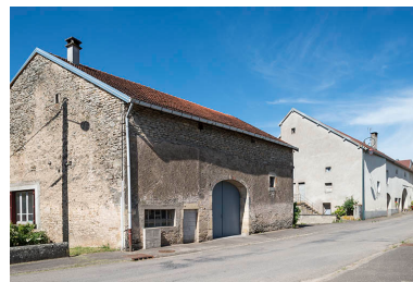
Ferme. Phot. Jérôme Mongreville IVR43_20177000742NUC4A
