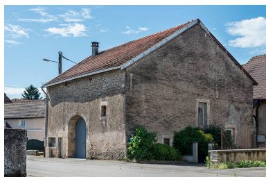
Ferme. Phot. Jérôme Mongreville IVR43_20177000741NUC4A
