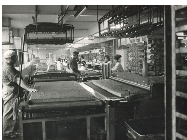
Laminage des plaques de pain d'épices, s.d. [vers 1960]. IVR43_20192500077NUC4A
