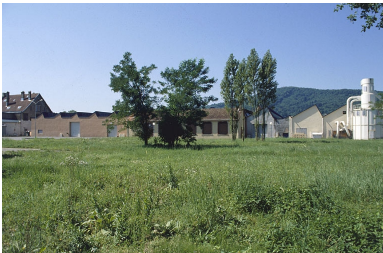
Pignons des ateliers depuis l'est.
