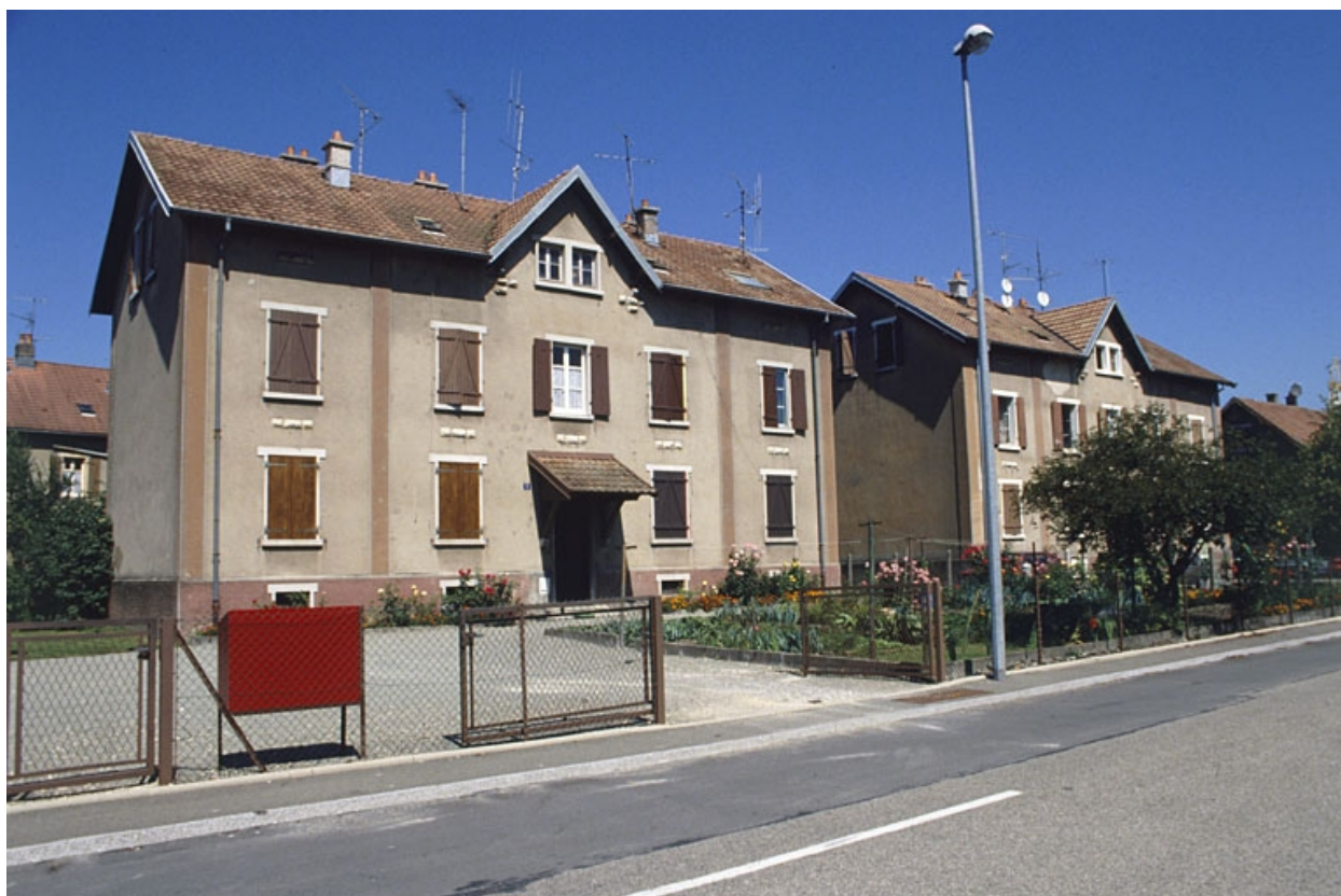
Logements collectifs ouvriers rue Georges Dollfus.
