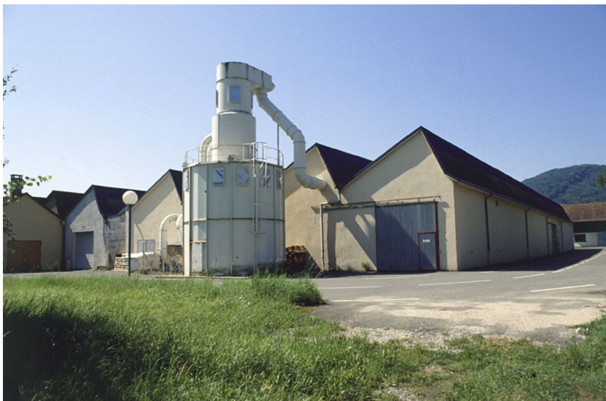
Extrémité nord des ateliers de fabrication.
