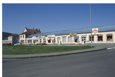
Vue rapprochée depuis le sud-est. Phot. Yves Sancey IVR43_20009000224ZA
