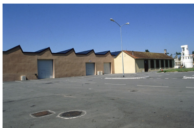
Pignons est des ateliers. Phot. Yves Sancey IVR43_20009000241ZA
