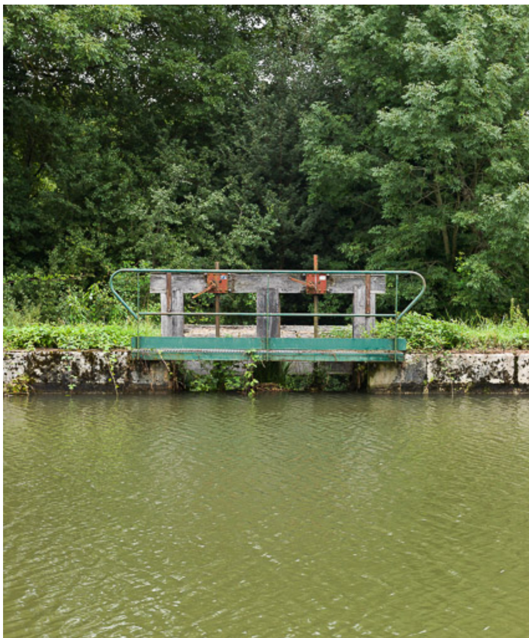
Vue du déversoir de fond.
