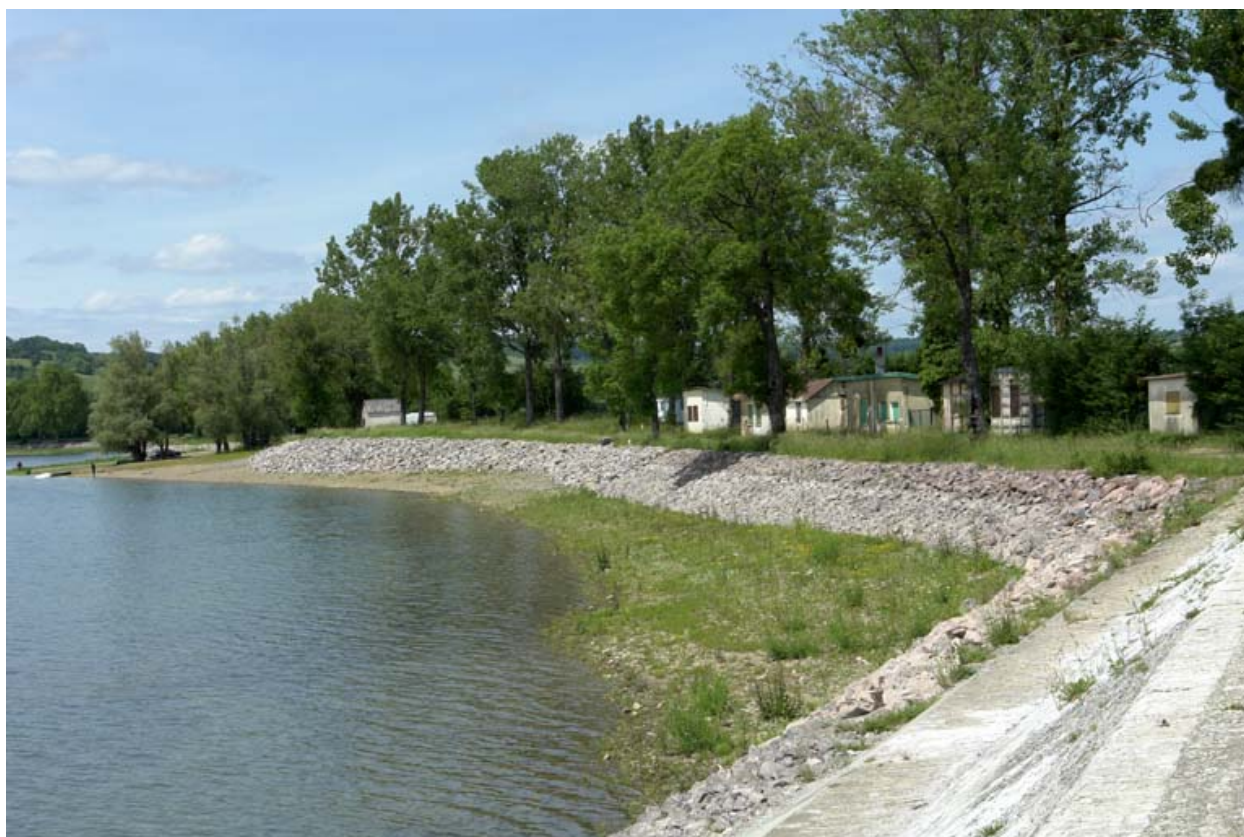
Digue est, extrémité nord.
