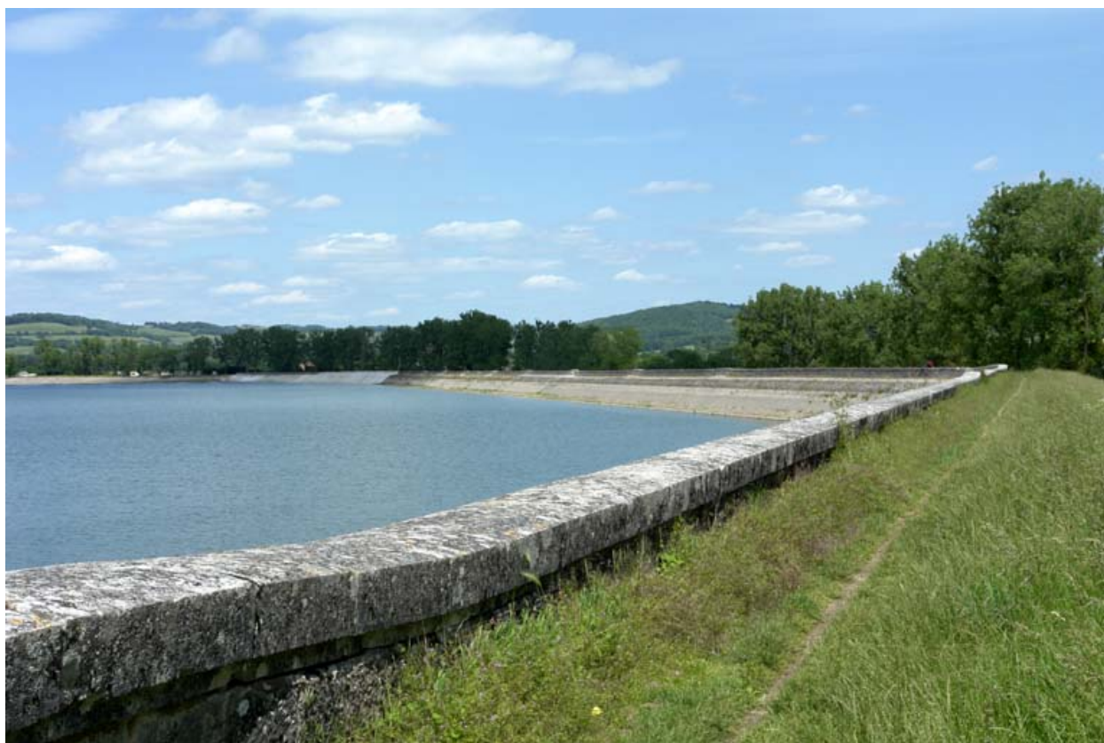
Digue est, vue d'ensemble.
