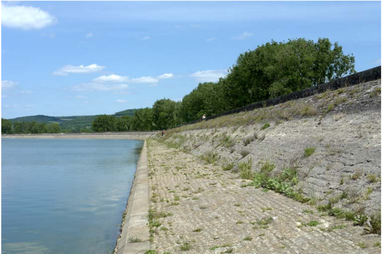
Digue est, vue d'ensemble.
