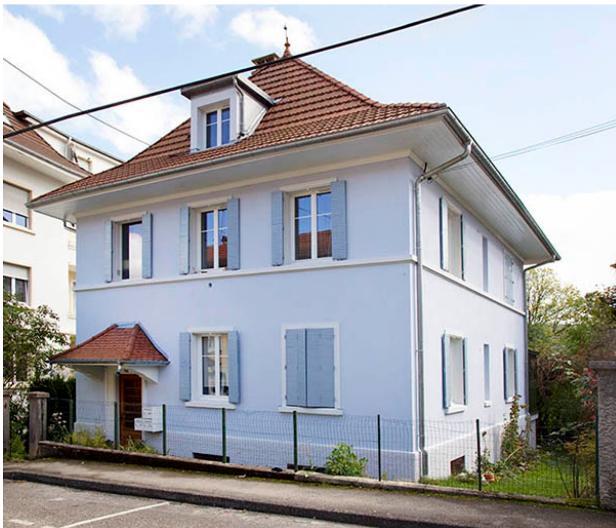
Façades antérieure et latérale droite.
