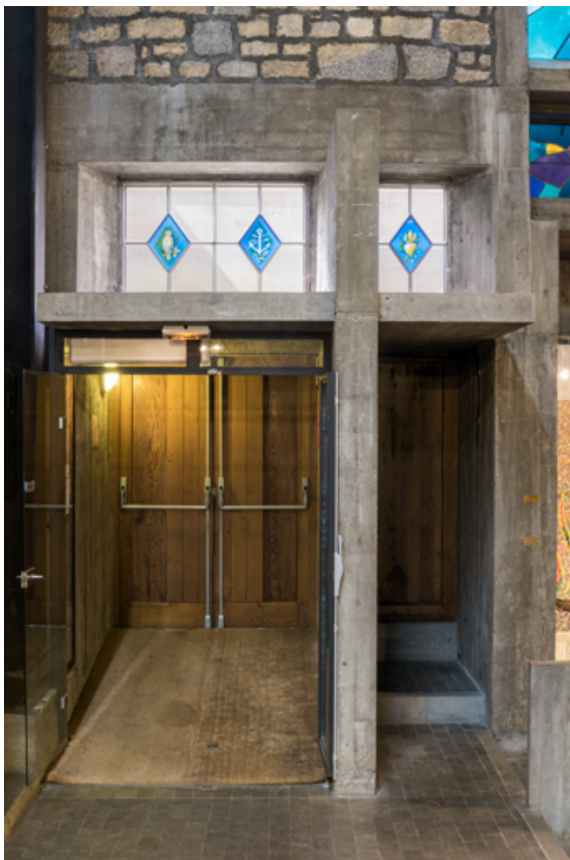
Verrières de la porte de la chapelle des fonts.
