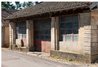
Vue générale. Phot. Jérôme Mongreville IVR43_20102500647NUC4A
