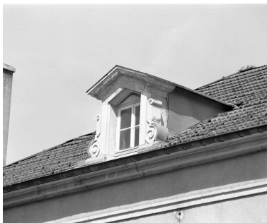
Détail d'une lucarne.
