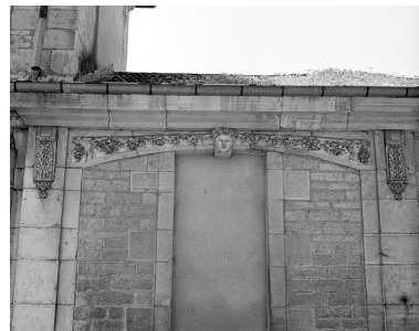
Détail du mur d'enclos côté Grande Rue.
