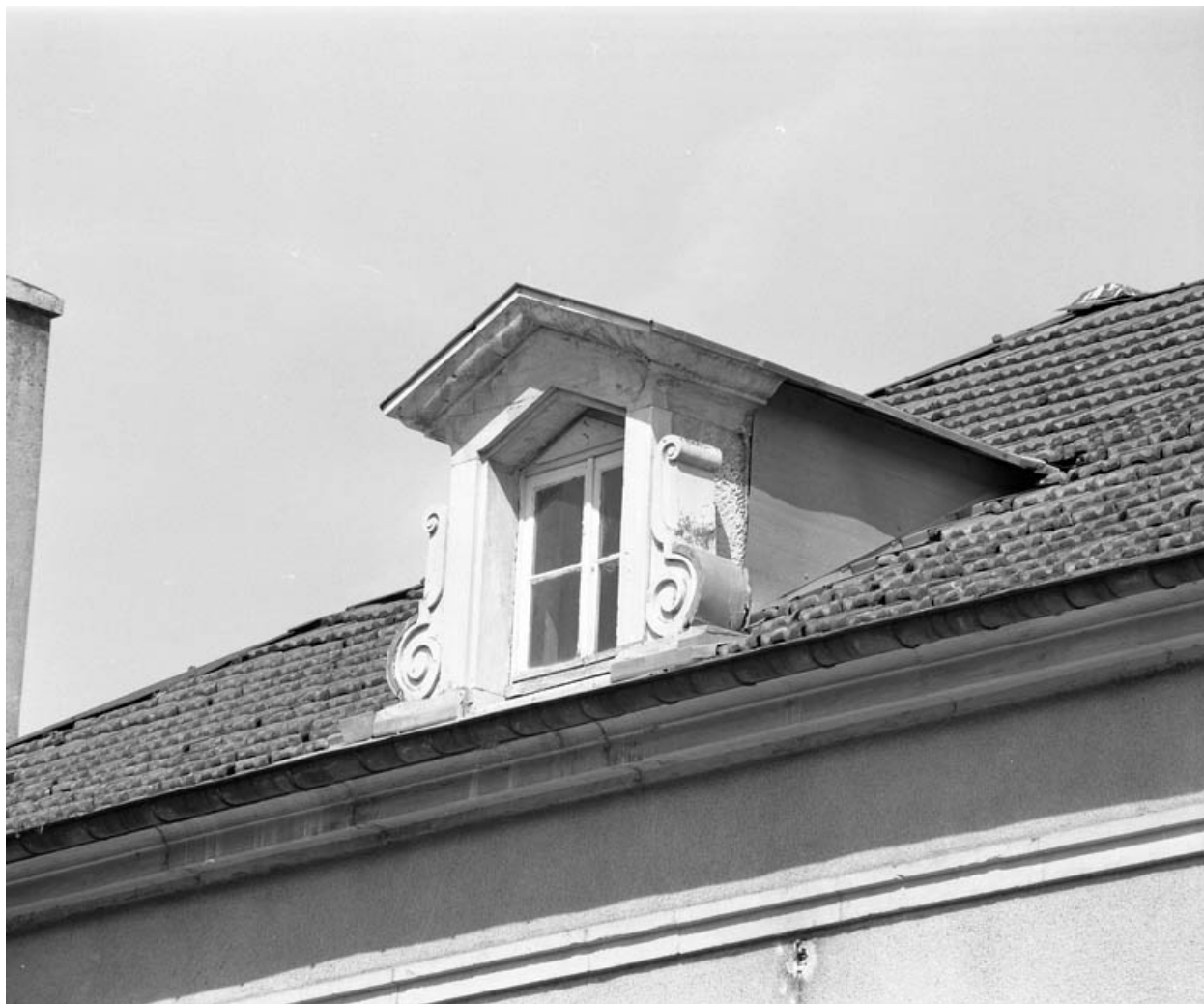
Détail d'une lucarne.
