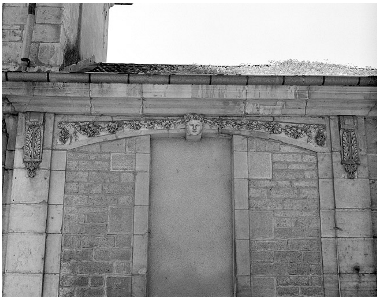
Détail du mur d'enclos côté Grande Rue.
