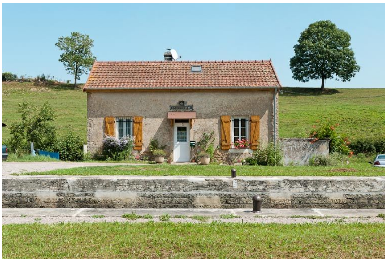
Vue de face de la maison éclusière.
