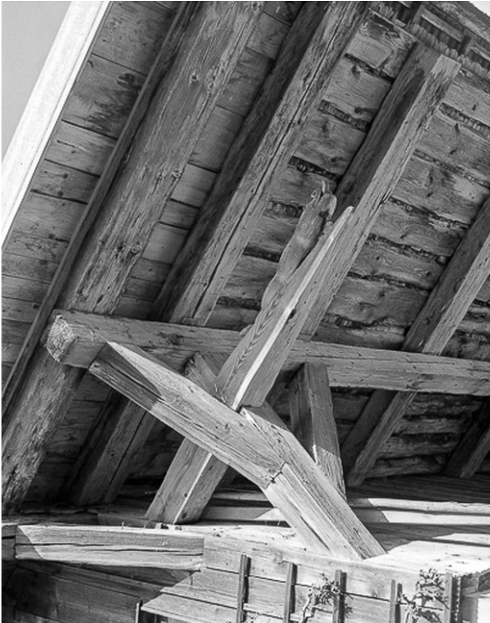
La ferme en 1976, arbalétriers côté nord : serpent (1er, à gauche).
