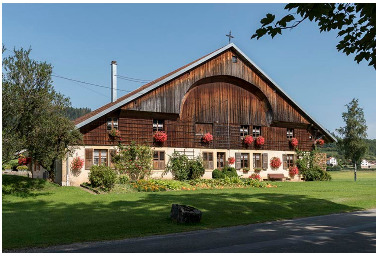
Ferme : façade antérieure, de trois quarts gauche.
