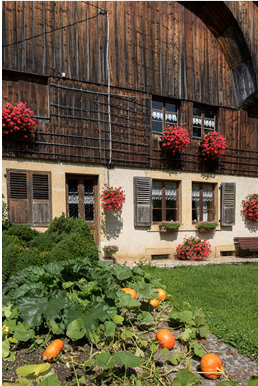
Ferme, façade antérieure : baies et lambrichure.
