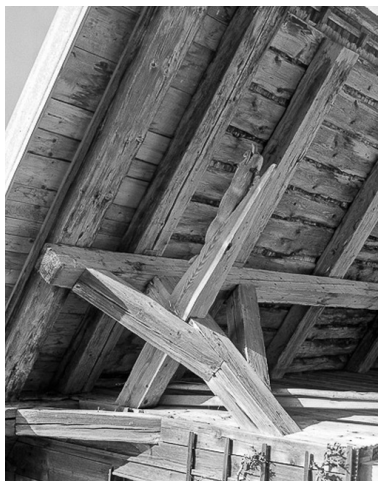
La ferme en 1976, arbalétriers côté nord : serpent (1er, à gauche). Phot. Dominique Humbert IVR43_19762500601X
