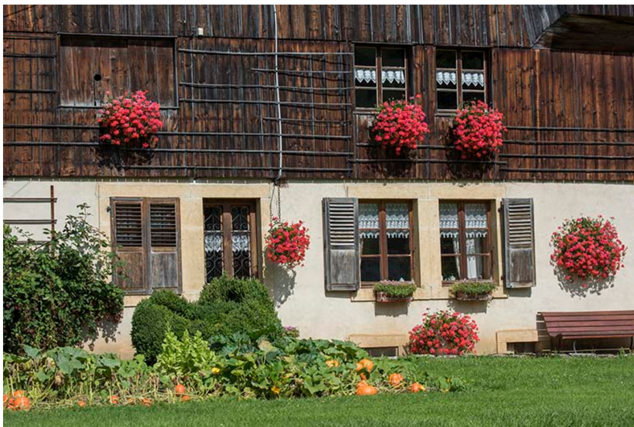
Ferme, façade antérieure : baies.
