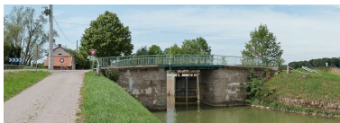
Vue du pont depuis l'aval.
