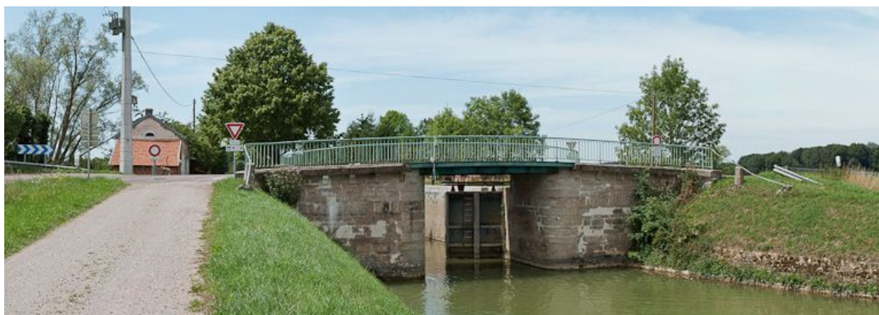
Vue du pont depuis l'aval.
