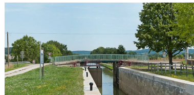
Vue du pont depuis l'amont.
