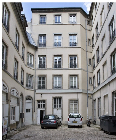
Logis principal, aile sur cour, de face.
