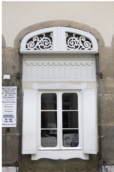
Logis secondaire : détail d'une baie du rez-de-chaussée. Phot. Yves Sancey IVR43_20122500540NUC2A
