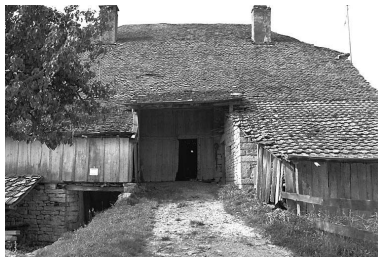
Face latérale droite : entrée de grange. Phot. Yves Sancey IVR43_19802500848X
