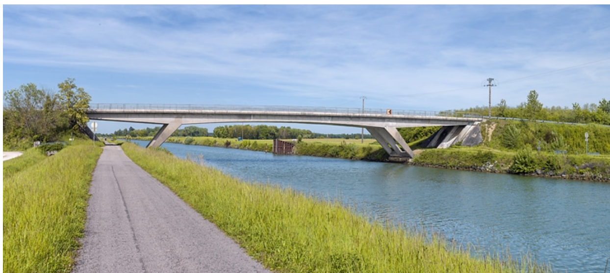
Vue d'ensemble d'amont, rive gauche.
