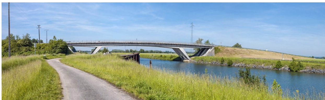
Vue d'ensemble d'amont, rive gauche.
