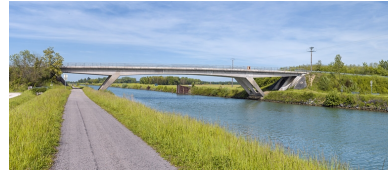
Vue d'ensemble d'amont, rive gauche.
