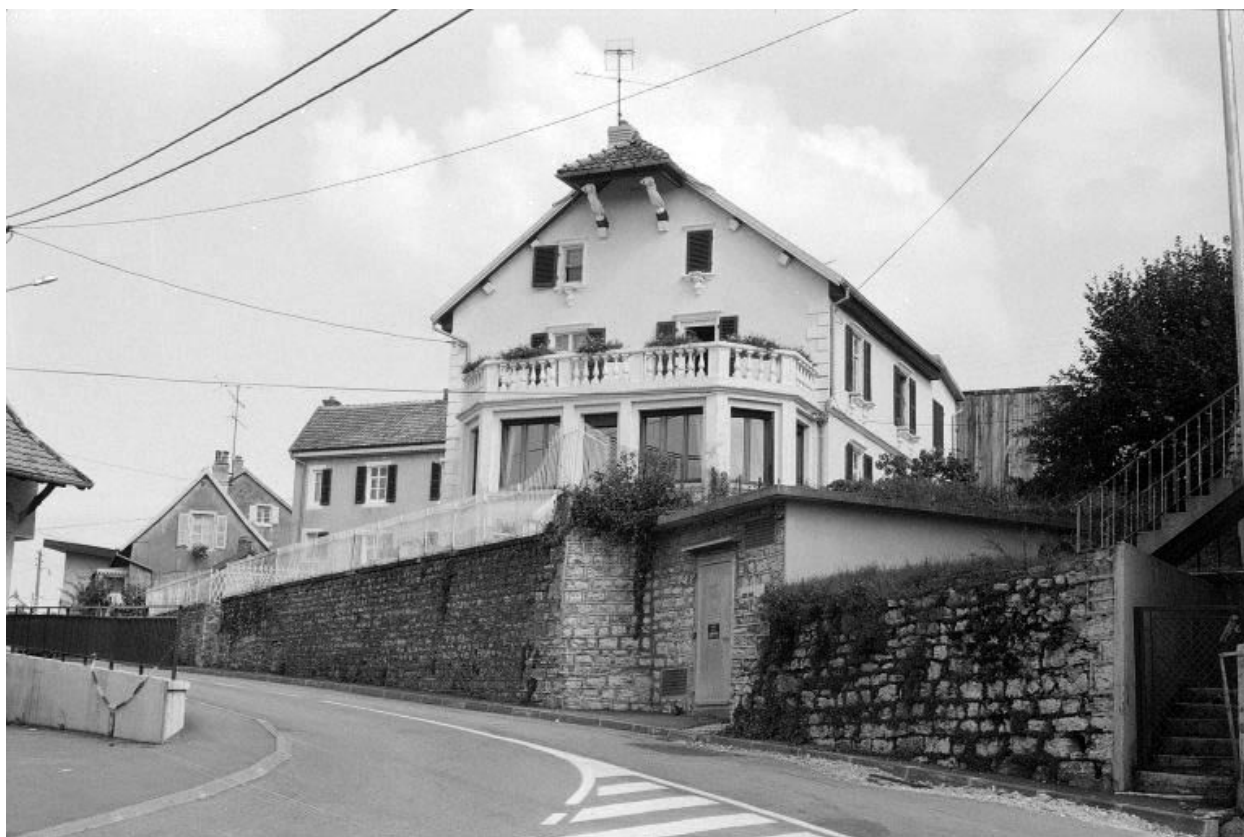
Façades latérale droite et postérieure.
