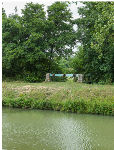
Vue de la prise d'eau.
