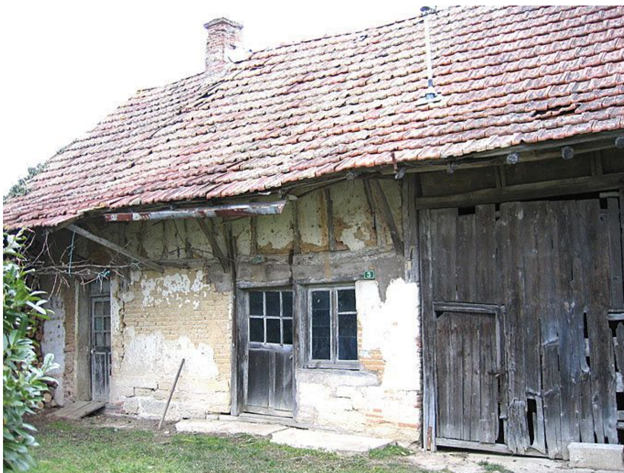
Vue d'ensemble de la façade.
