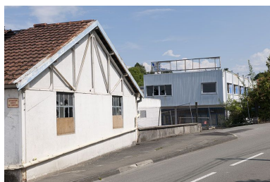
Pignon d'un atelier et bureaux. Phot. Jérôme Mongreville IVR43_20112501237NUC4A
