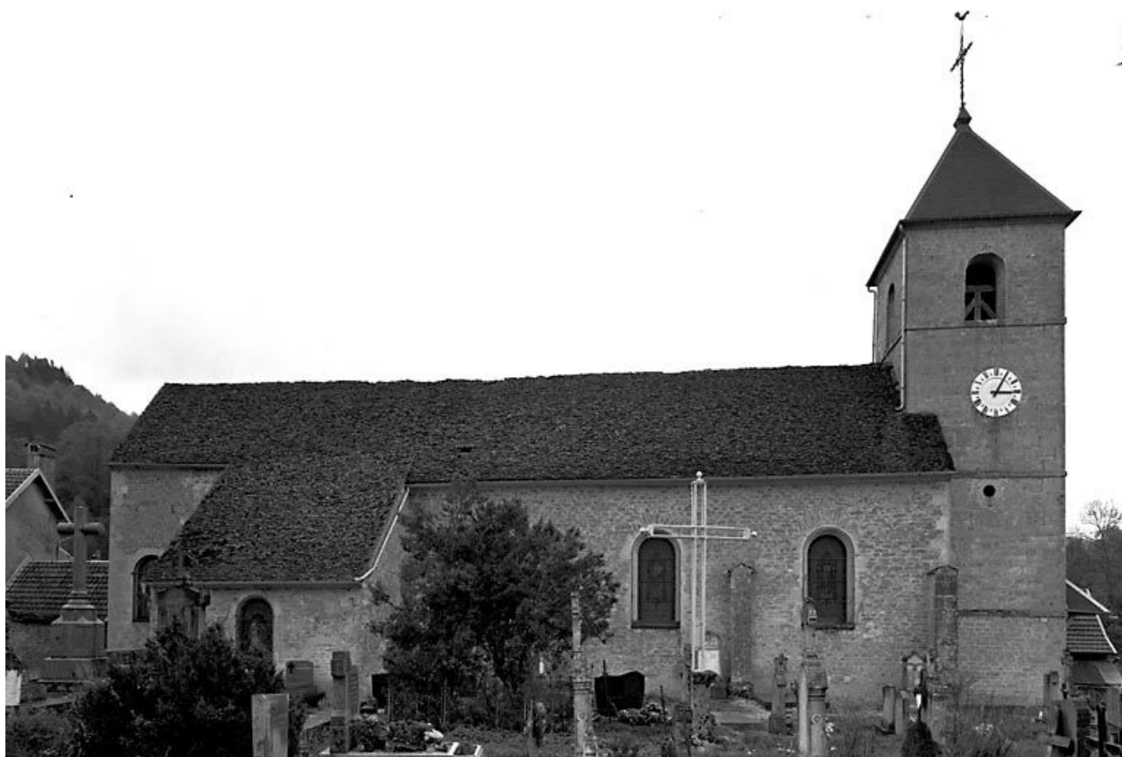
Face latérale nord.
