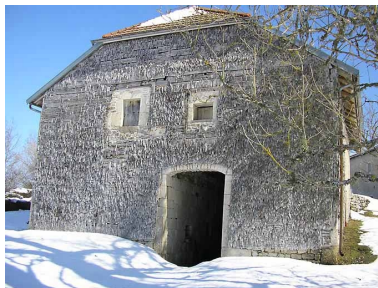
Vue du pignon avec essentage. Phot. Marie-Pierre Reynet IVR43_20083900238NUC1A
