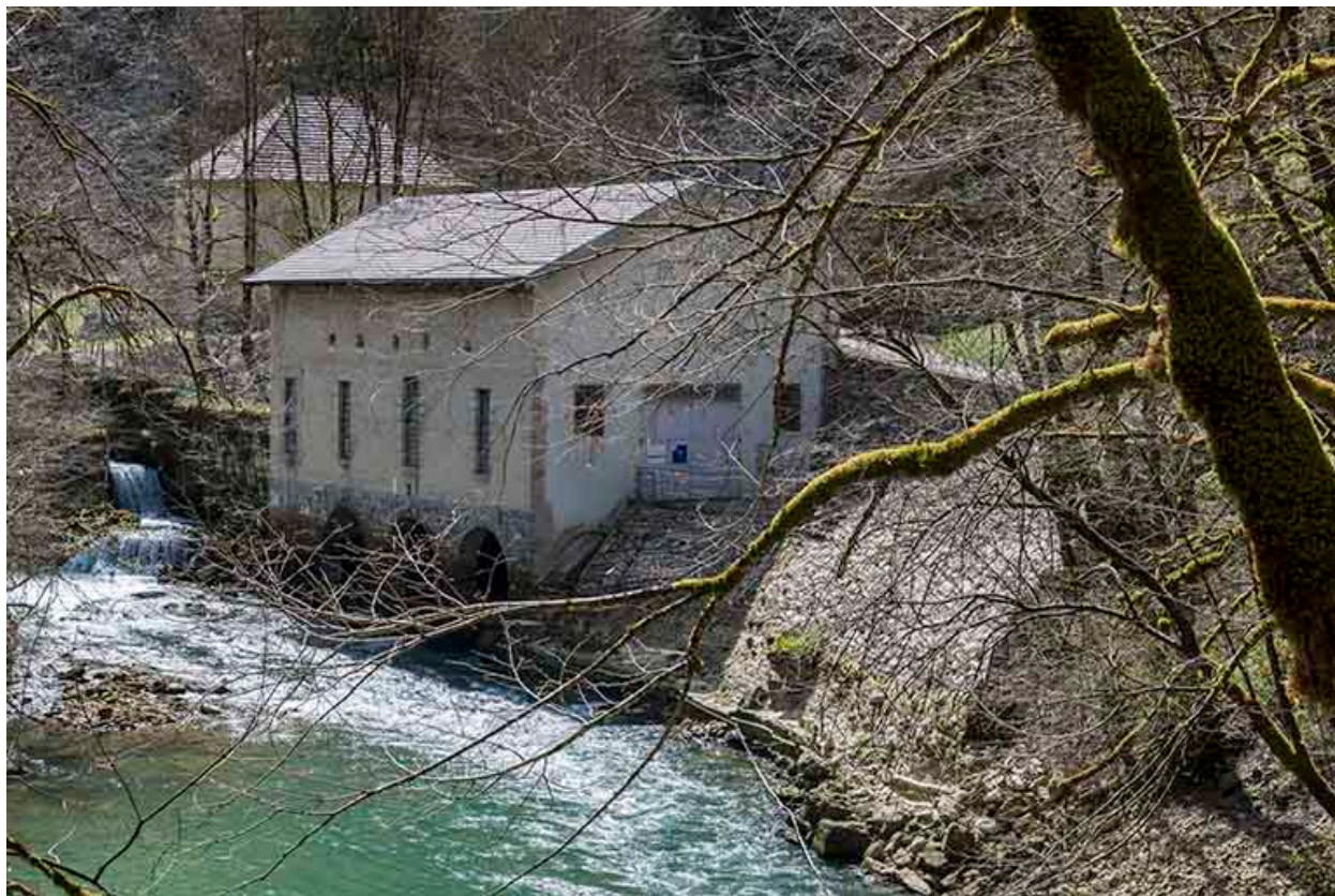
La centrale depuis l'aval.
