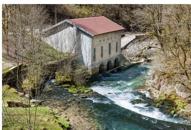
La centrale hydroélectrique depuis l'amont. Phot. Jérôme Mongreville IVR43_20152501152NUC4A
