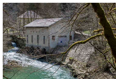
La centrale depuis l'aval. Phot. Jérôme Mongreville IVR43_20152501142NUC4A
