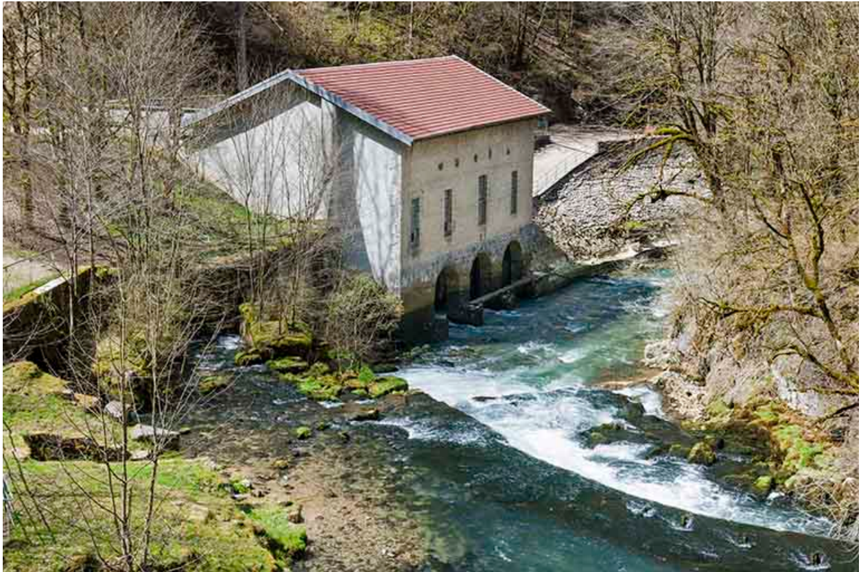
La centrale hydroélectrique depuis l'amont.
