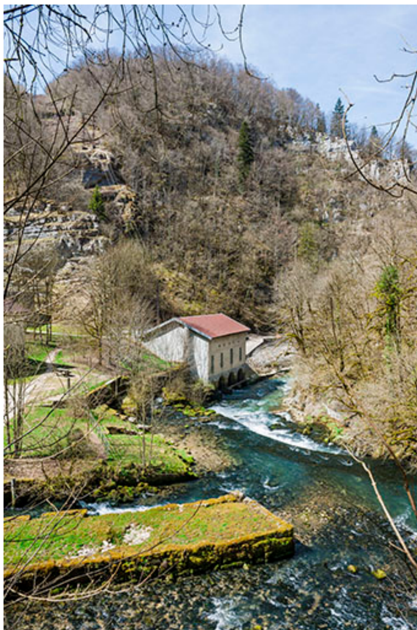
Vue plongeante sur la centrale.
