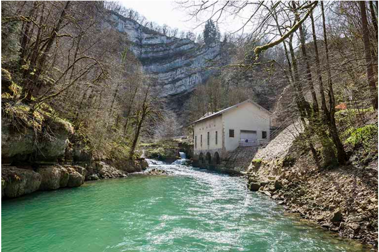
Vue générale depuis l'aval.
