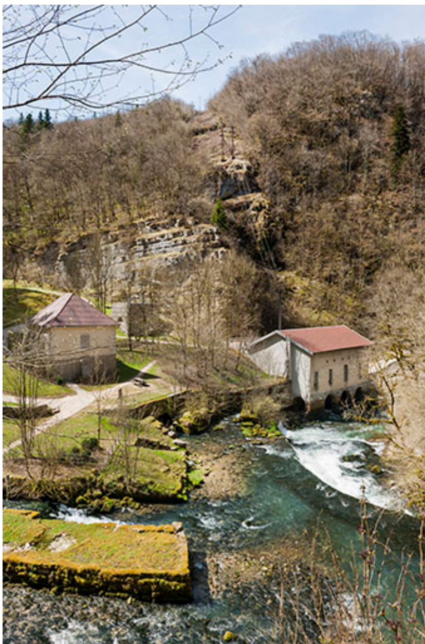
Vue d'ensemble plongeante depuis le sud.
