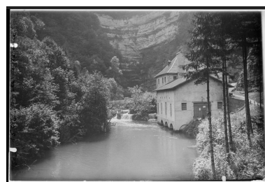
Vue d'ensemble depuis l'aval, fotogr., s.d. [vers 1930]. Phot. Jules Manias
