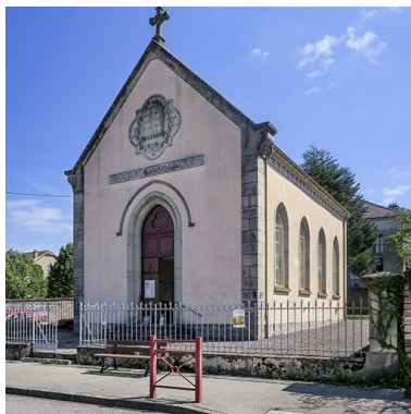
Vue d'ensemble. Phot. Fabien Dufoulon IVR43_20217000438NUC2A
