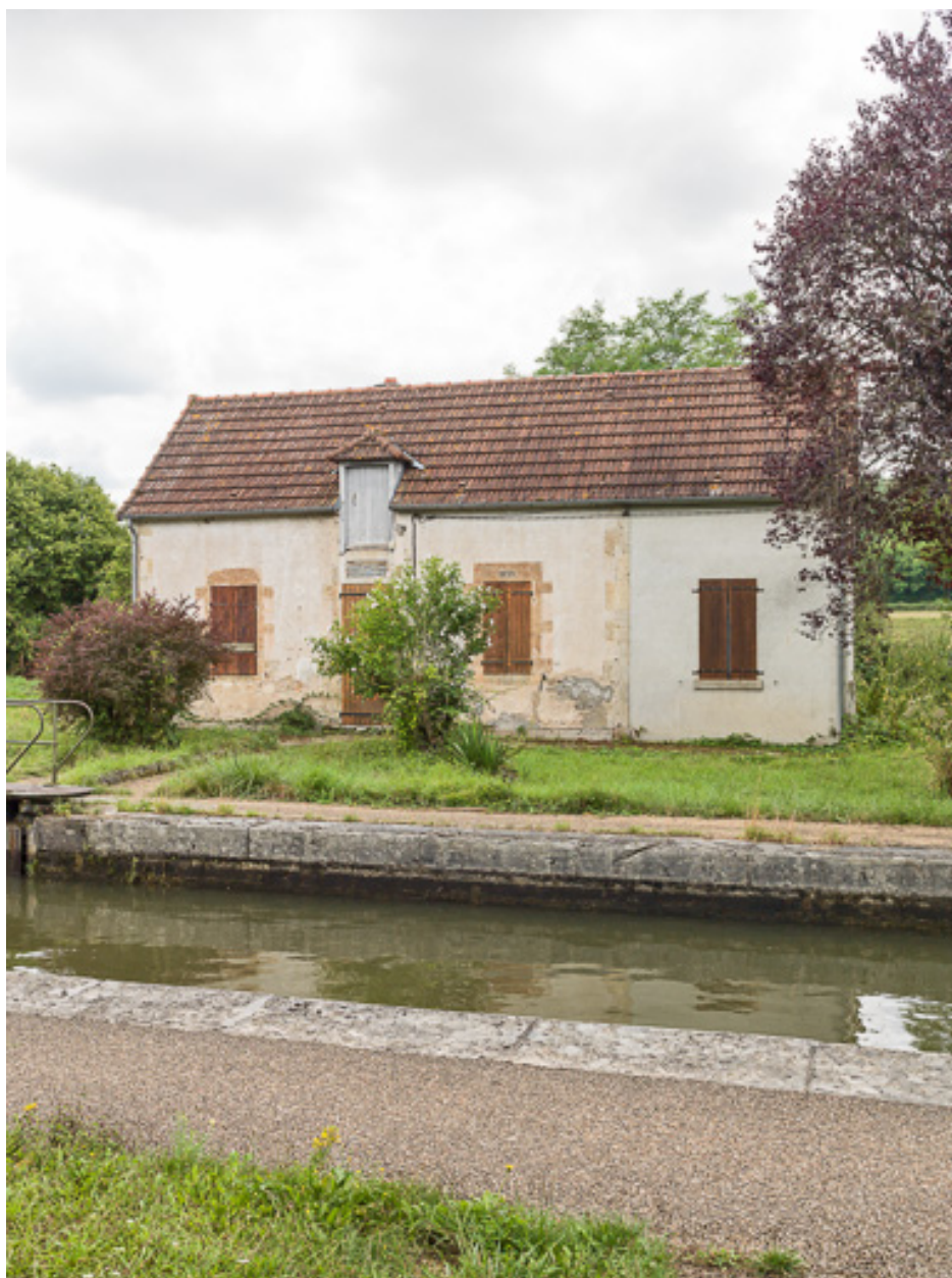
Vue de la maison éclusière.
