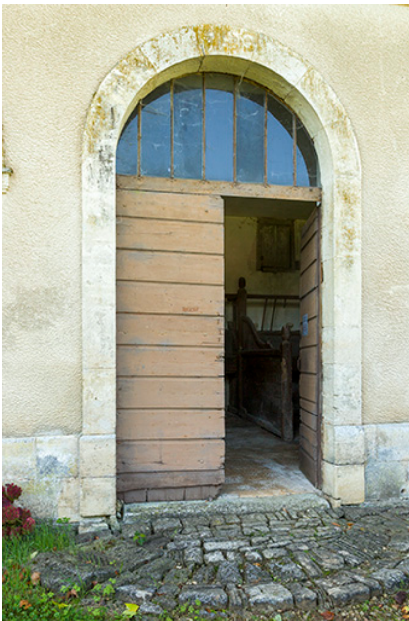
Ecurie, façade nord-est : la porte.
