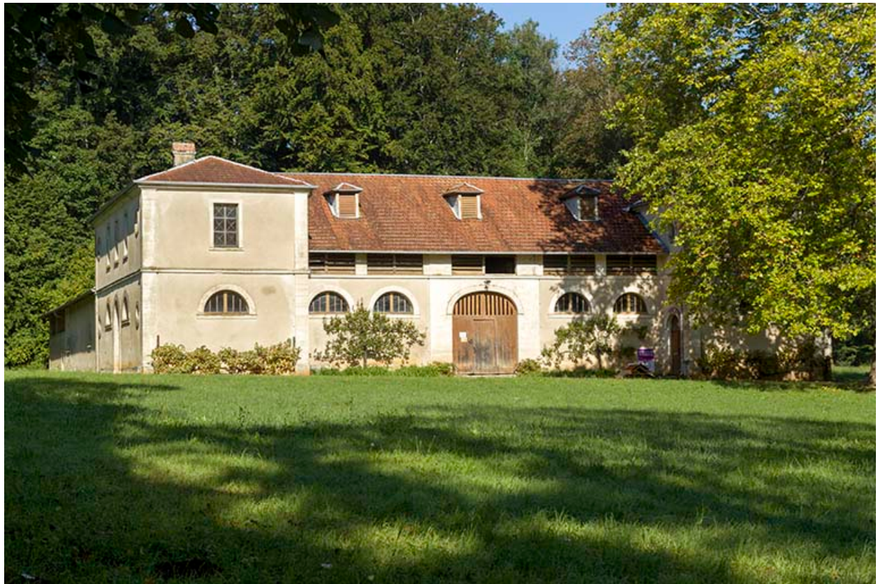
Vue générale de la façade sud-est.
