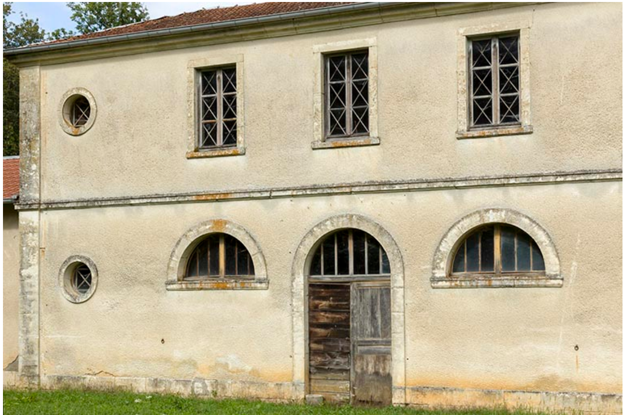
Etable : vue générale de la façade sud-ouest.
