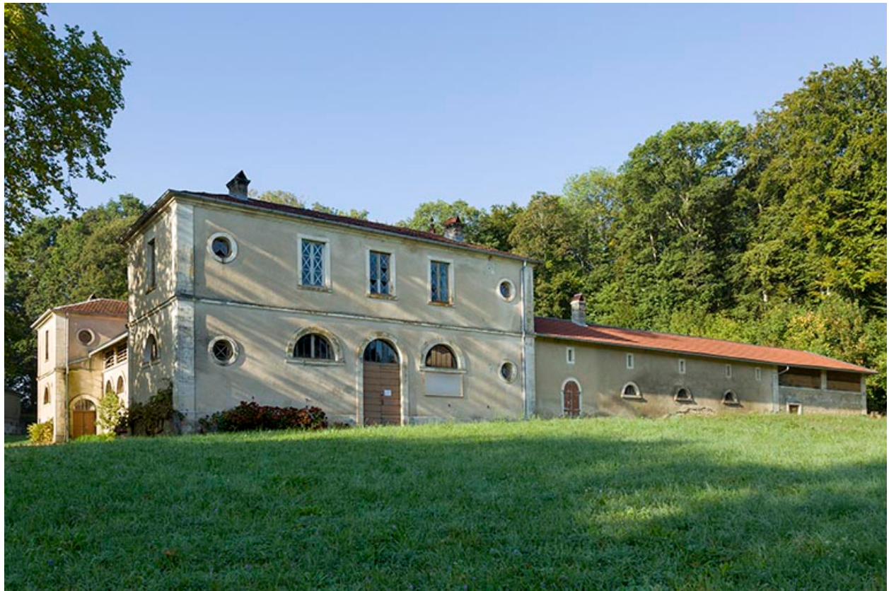
Ecurie : façade nord-est.
