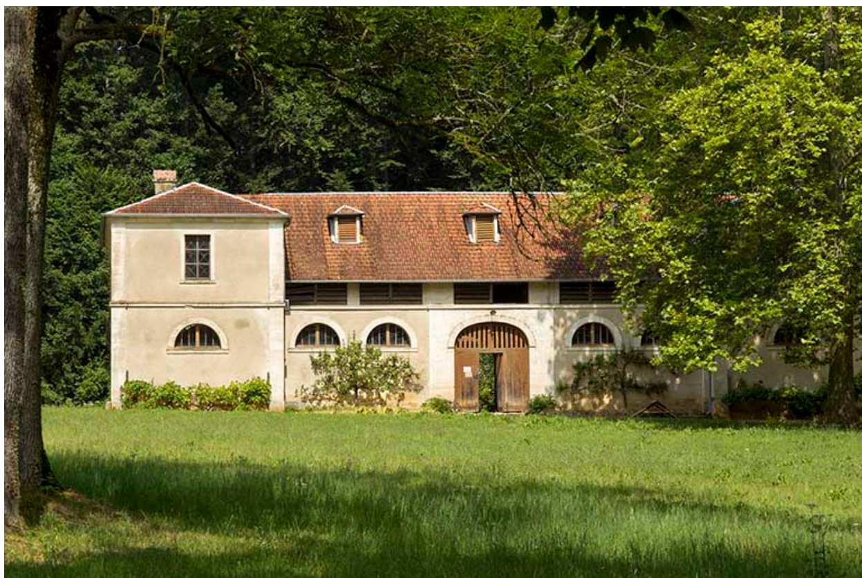
Vue rapprochée de la façade antérieure.
