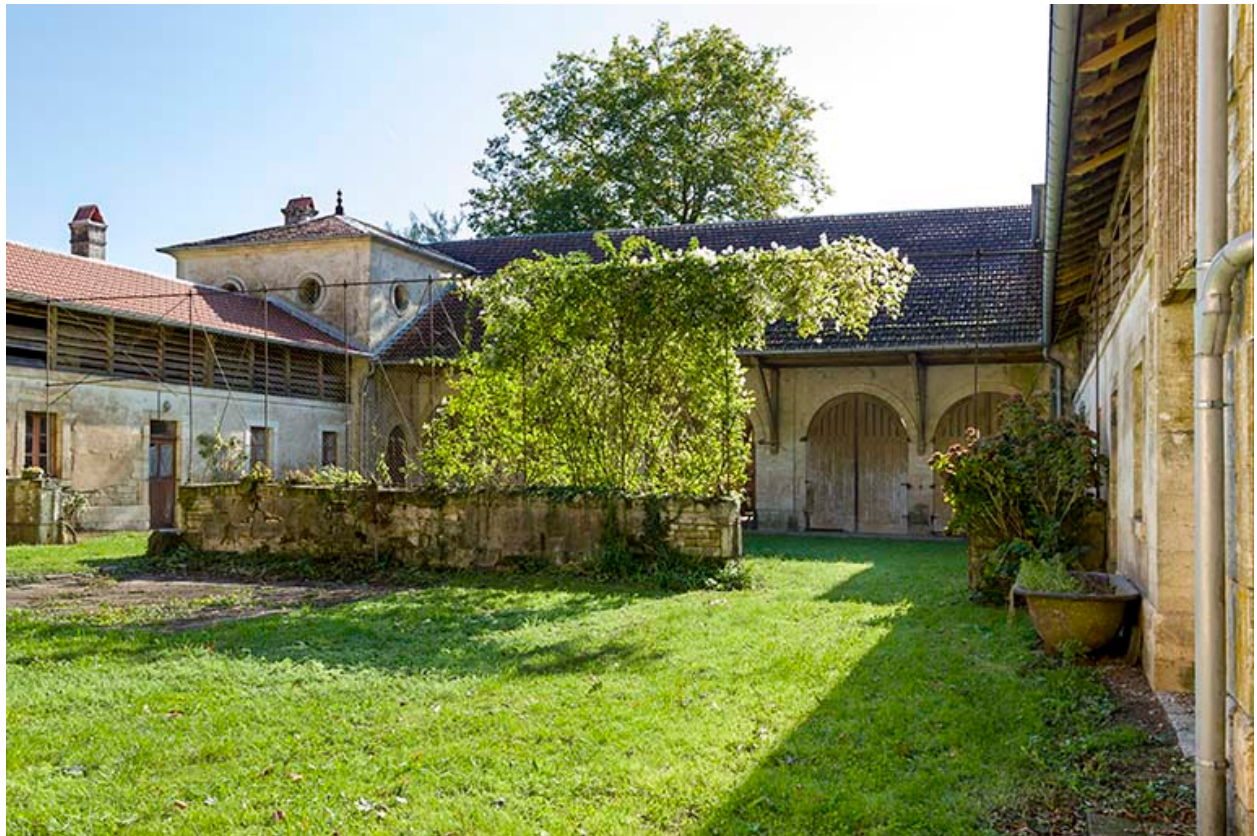
Le corps principal depuis la cour.
