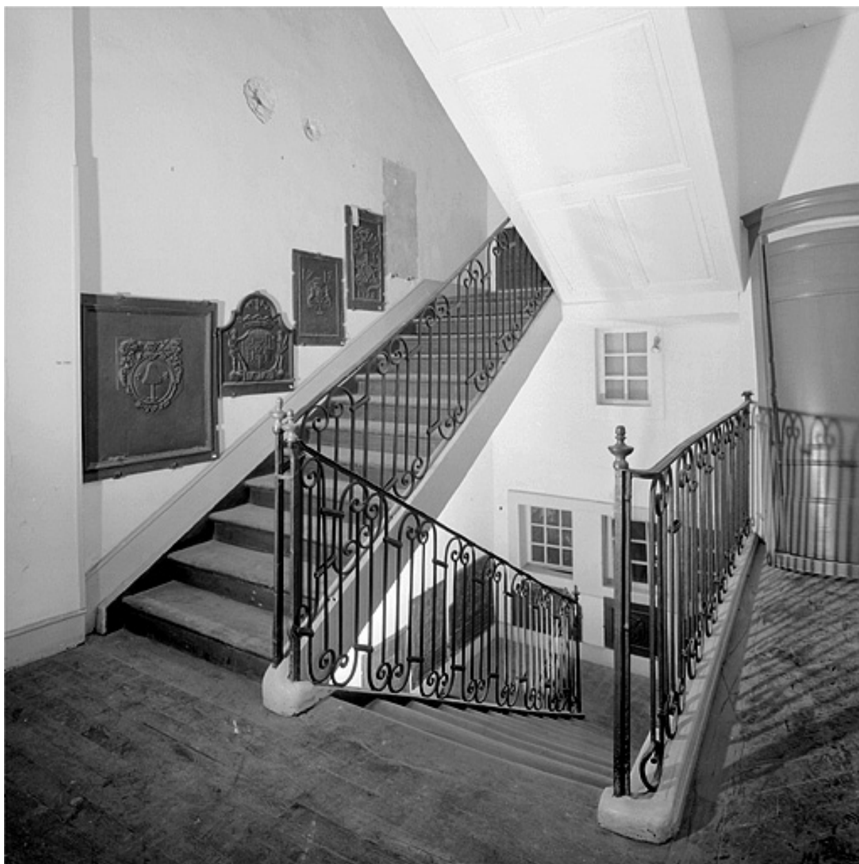
Escalier vu du palier du premier étage.
