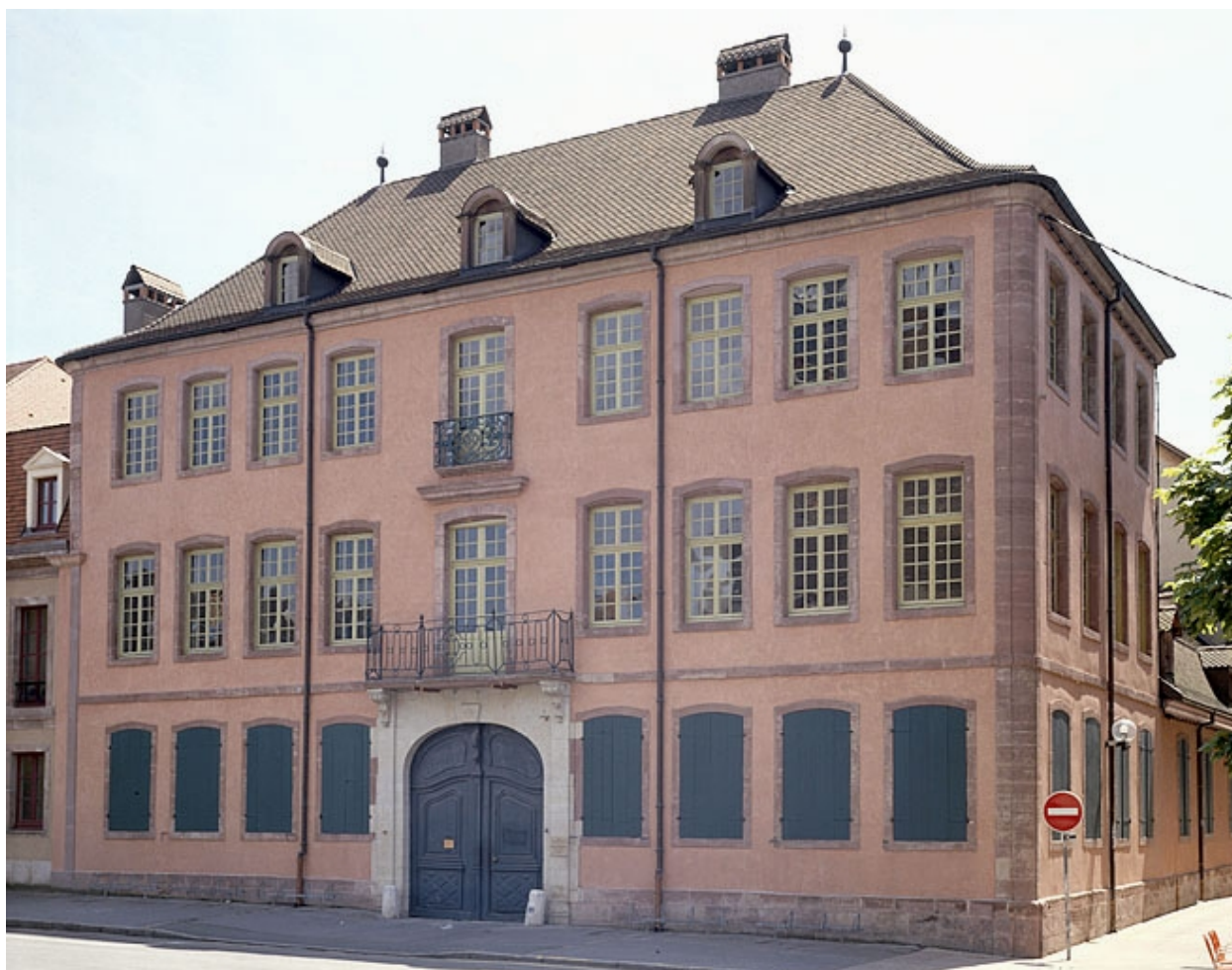
Façade principale sur la place Saint-Martin.
