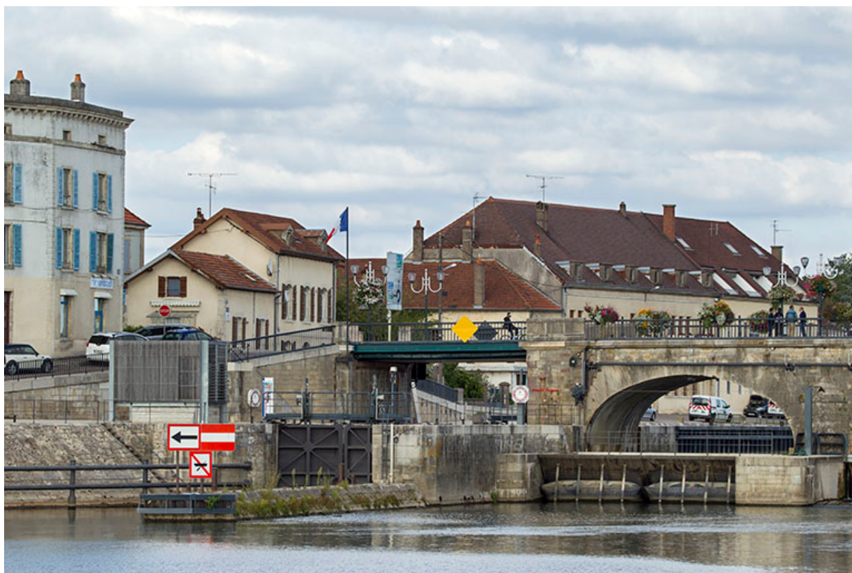
Le site d'écluse, vue aval.
