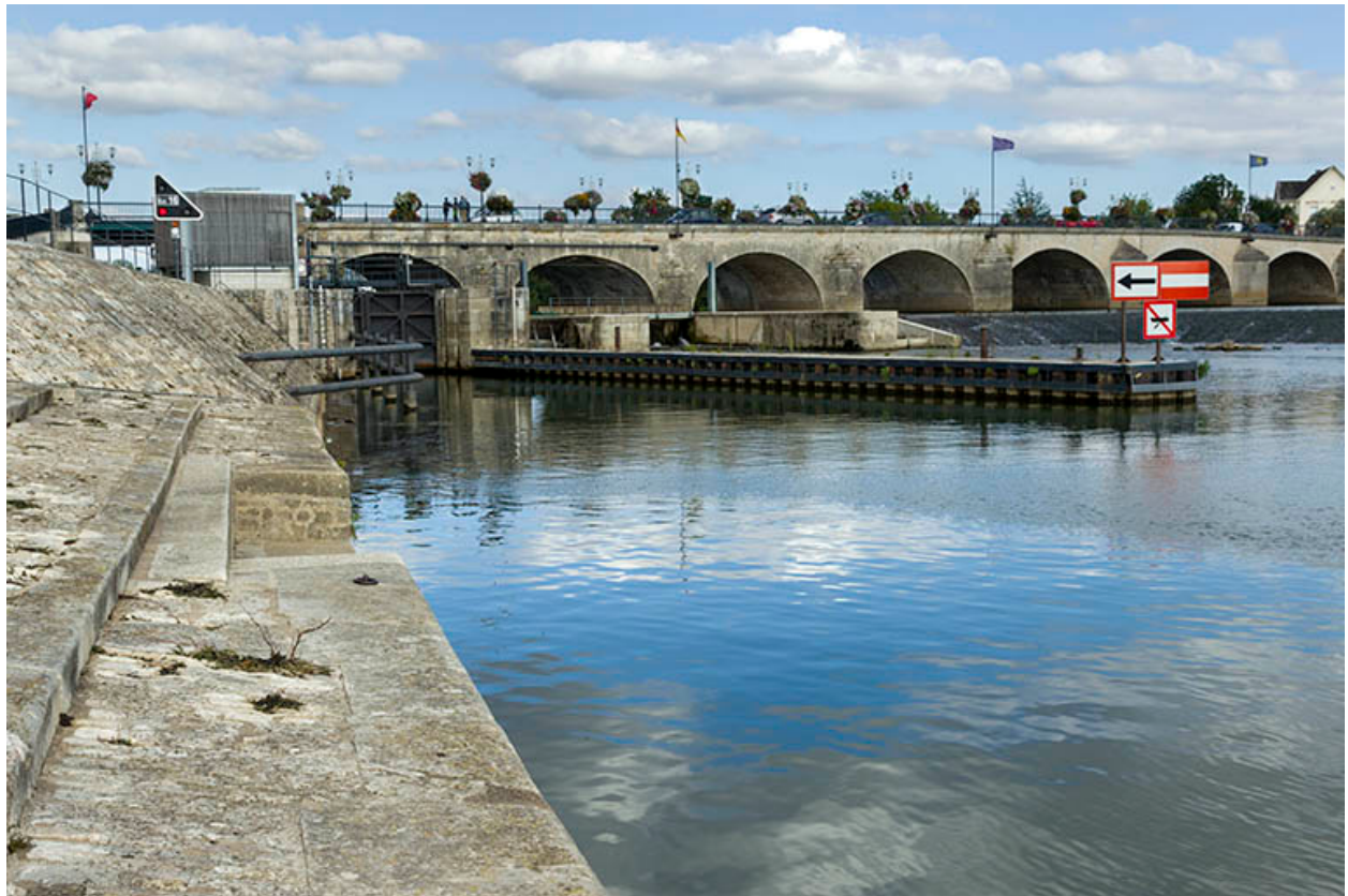
L'écluse, vue aval.
