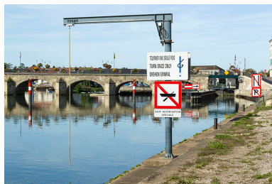
Instrument permettant d'ouvrir l'écluse de manière automatique. Phot. Sonia Dourlot IVR43_20157000870NUC2A
