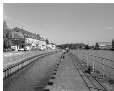
Vue de l'écluse le long du quai Vergy. Phot. Yves Sancey IVR43_19887000065X
