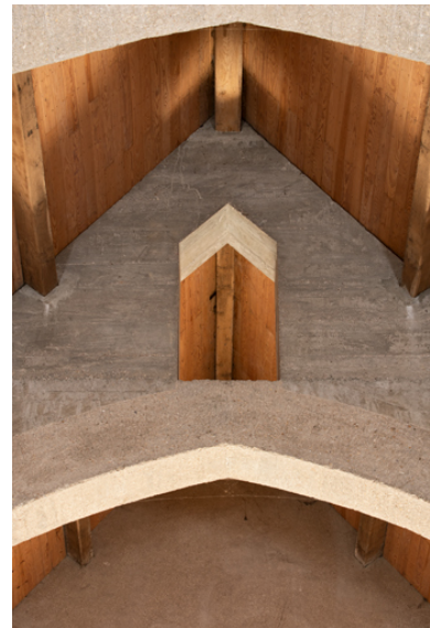
Charpente, détail d'un arc en béton armé. Phot. Pierre-Marie Barbe-Richaud IVR26_20248900143NUC4A
