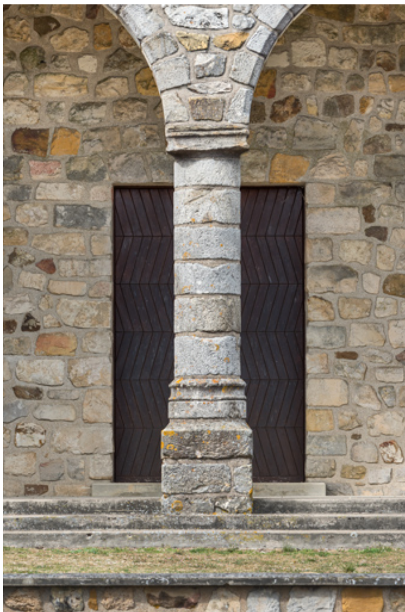
Façade antérieure, détail de la colonne du porche.
