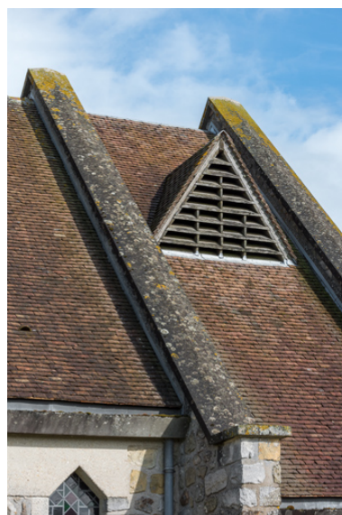
Toiture du porche, détail de la lucarne close par des abat-sons. Phot. Pierre-Marie Barbe-Richaud IVR26_20238901114NUC4A
