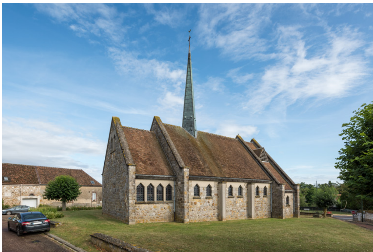
Elévations ouest, vue d'ensemble.
