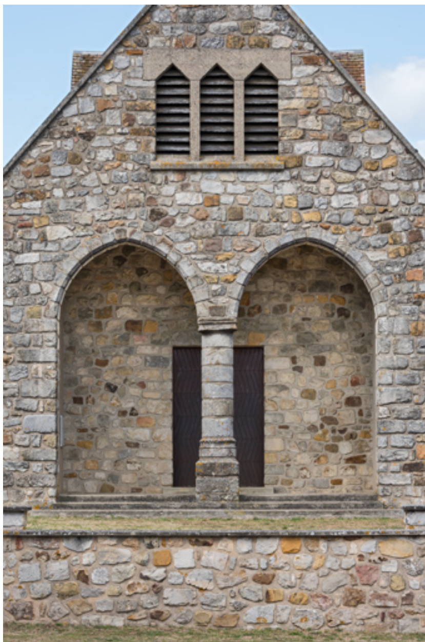
Façade antérieure, détail du porche.
