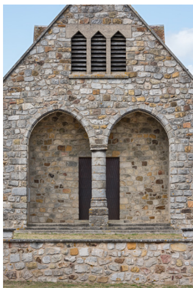
Façade antérieure, détail du porche. Phot. Pierre-Marie Barbe-Richaud IVR26_20238901107NUC4A
