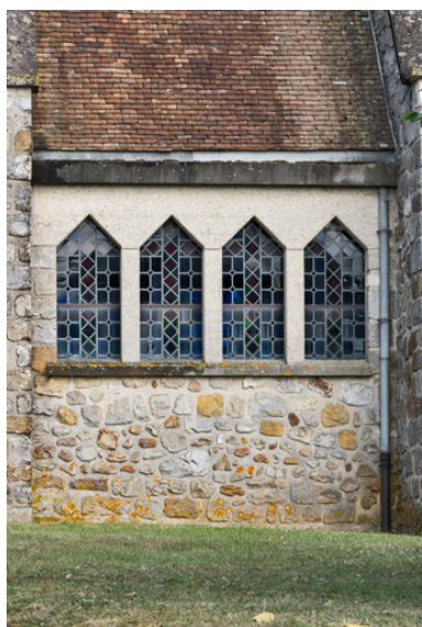
Baies du chœur. Phot. Pierre-Marie Barbe-Richaud IVR26_20238901115NUC4A
