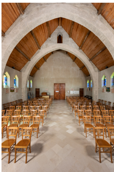
Nef, vue en direction de l'entrée porte fermée. Phot. Pierre-Marie Barbe-Richaud IVR26_20248900145NUC4A
