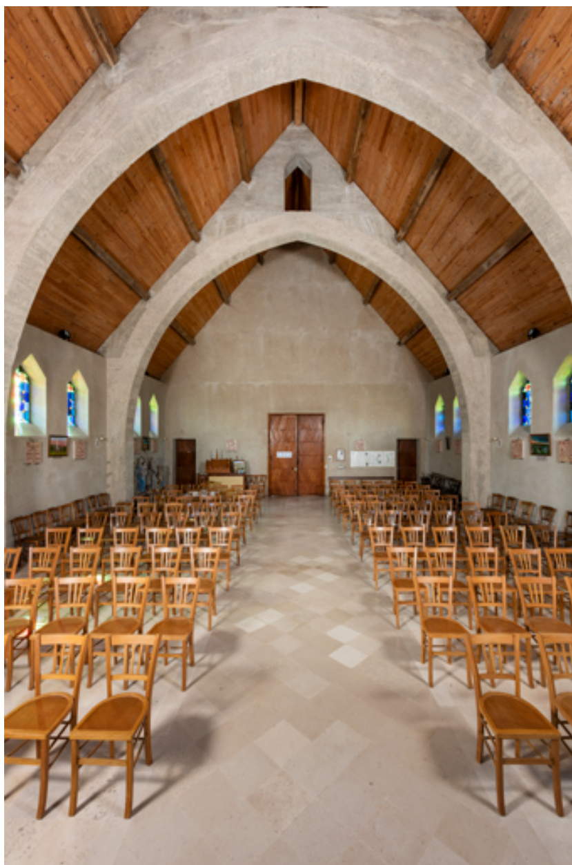
Nef, vue en direction de l'entrée porte fermée.
