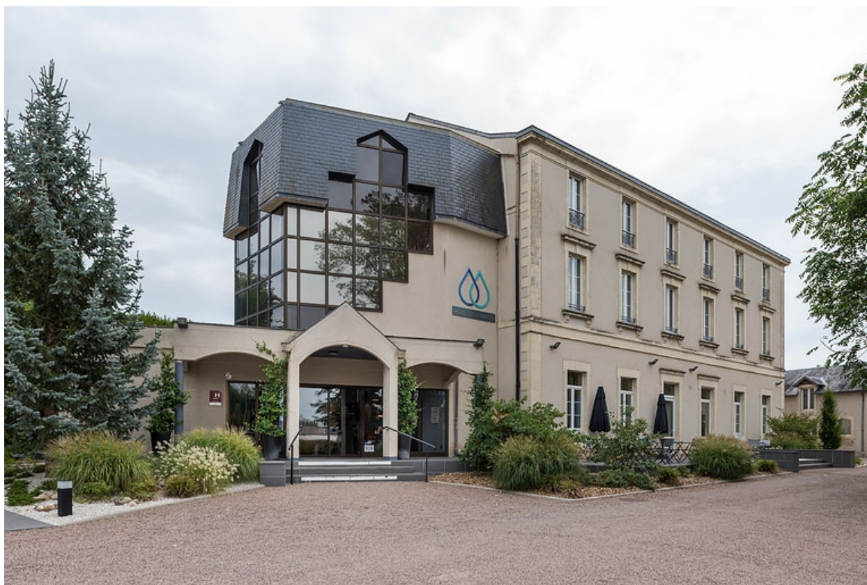
Façade après les travaux de modernisation de 2017.
