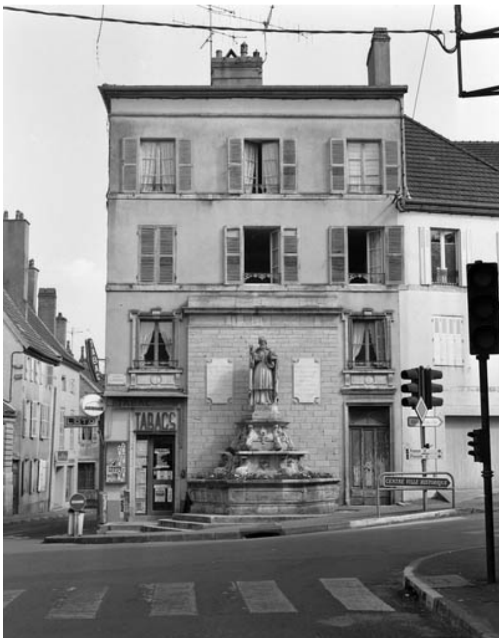
Façade antérieure, de face.
