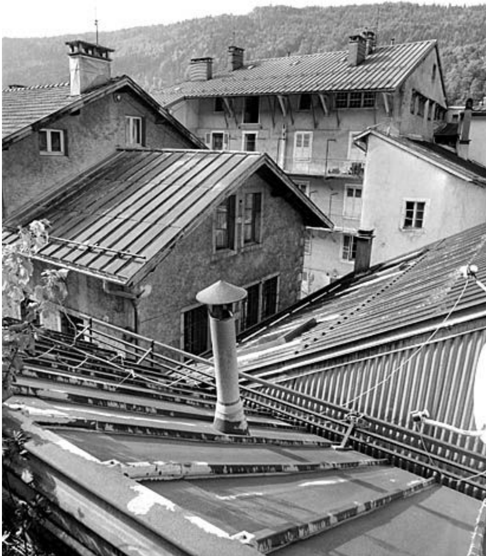
Toitures des bâtiments est et nord-est.
