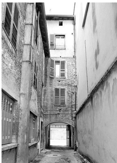
Façade postérieure du n° 141 et passage. Phot. Yves Sancey IVR43_20033900323X
