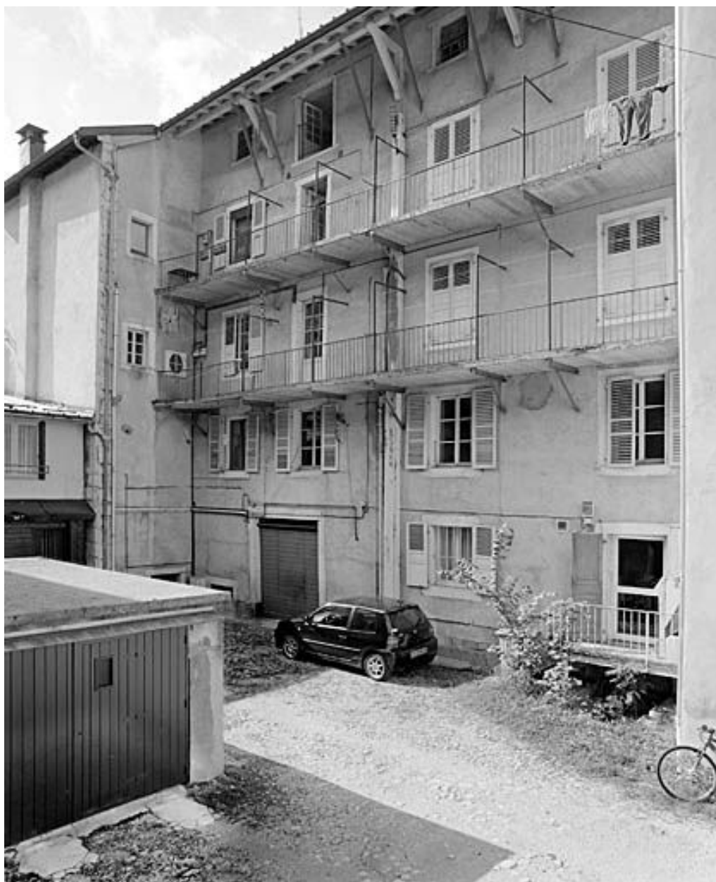
Façade postérieure du n° 143.
