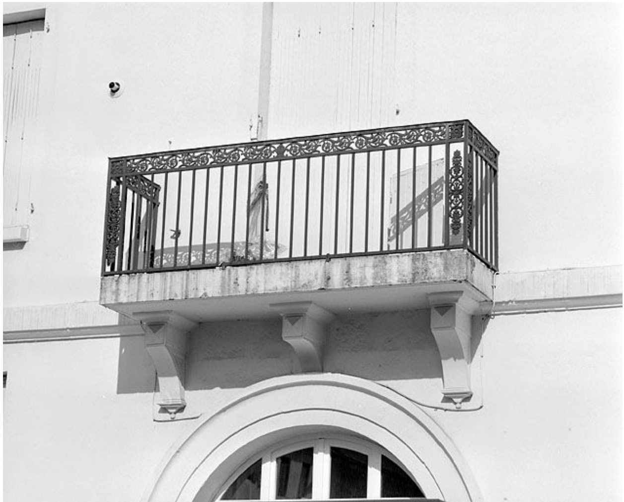
Façade latérale droite : balcon du premier étage.
