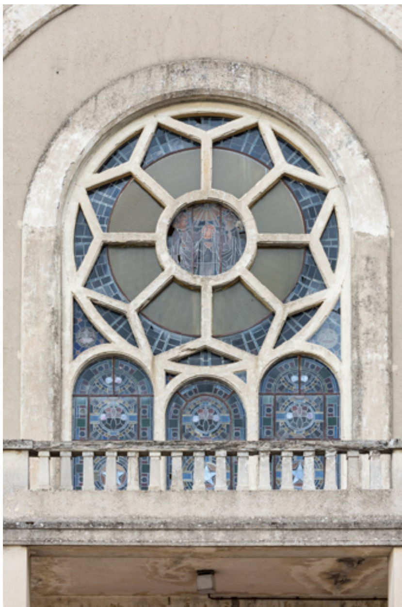
Verrière de la façade ouest. Vue extérieure.
