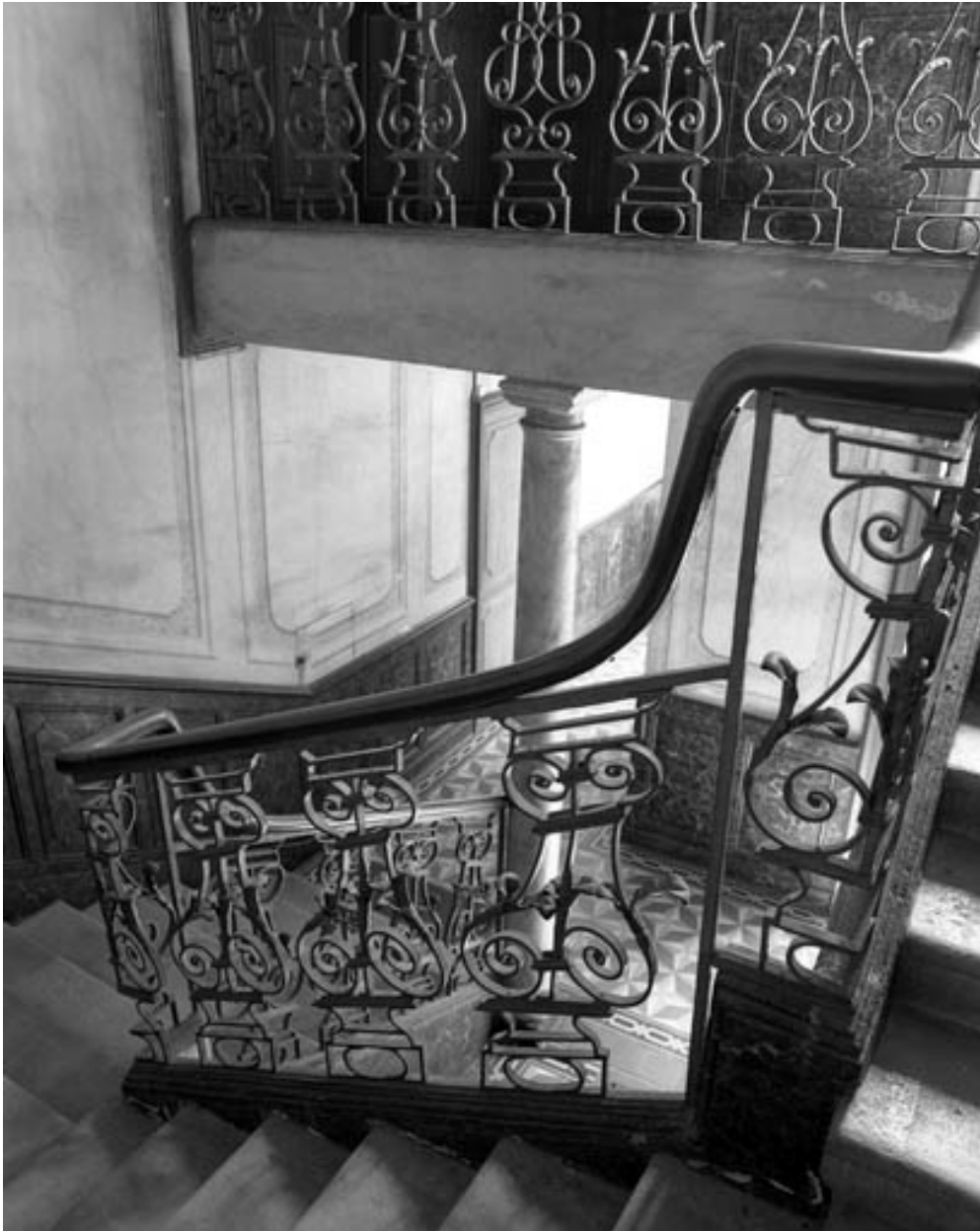
Escalier d'honneur : détail de la rampe d'escalier.
