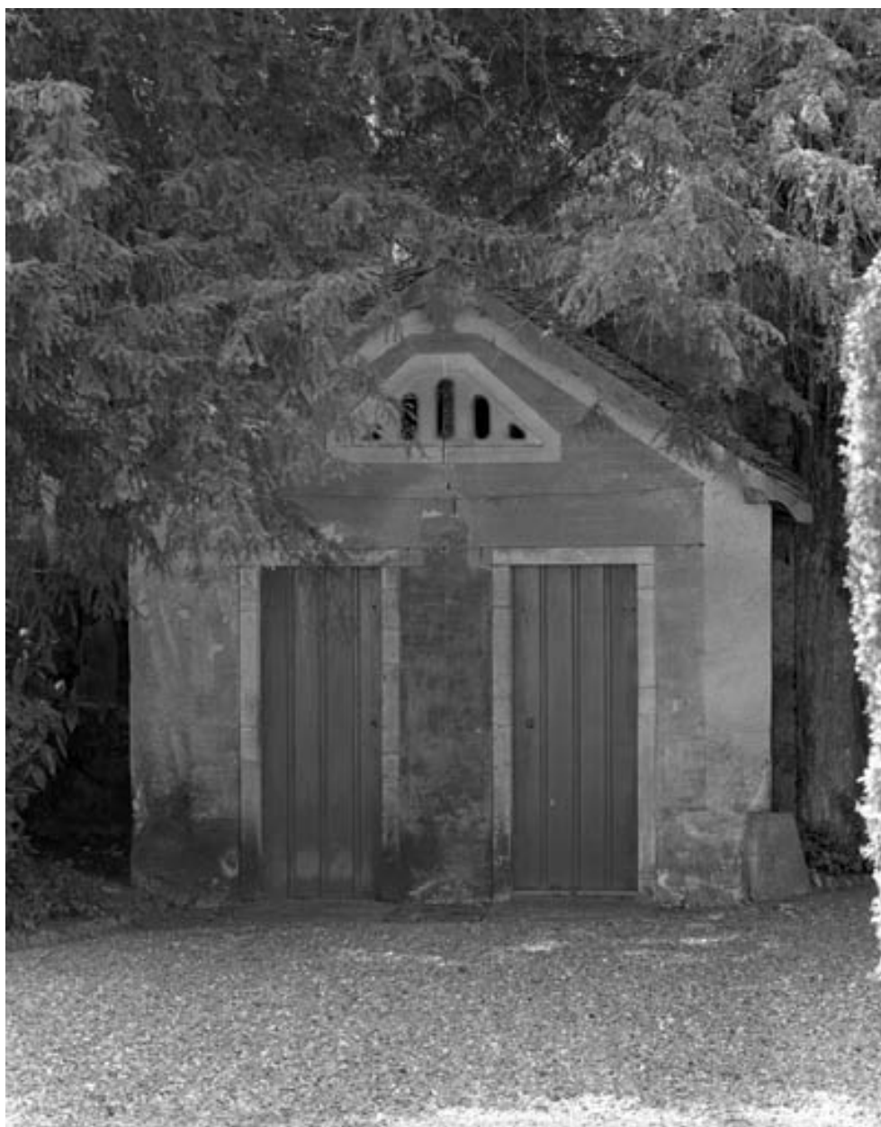
Détail des lieux d'aisance destinés au personnel.
