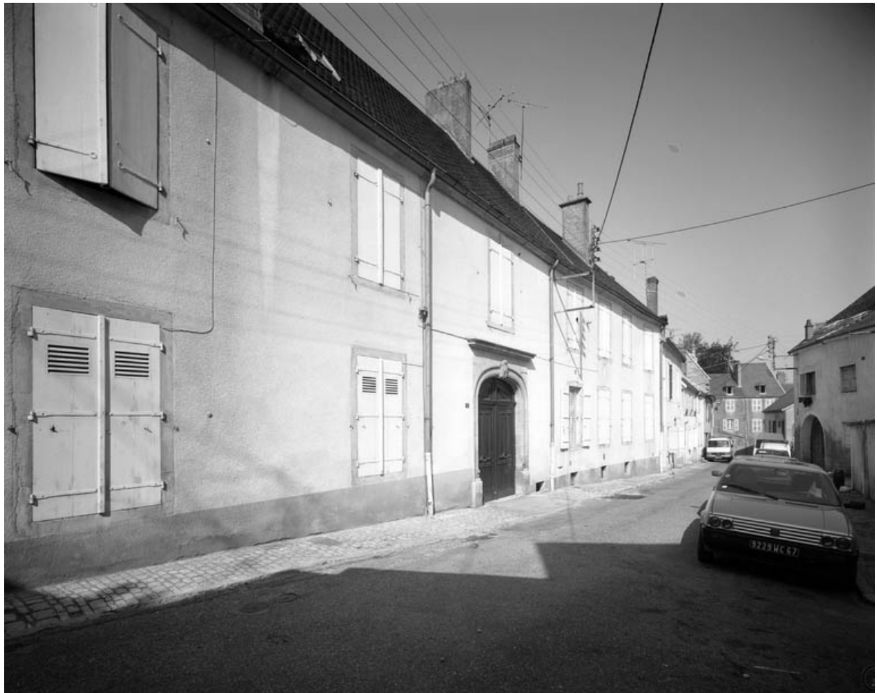
Façade sur rue, de trois quarts gauche.
