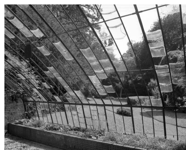
Serre : détail de la verrière. Phot. Yves Sancey IVR43_19917000367X
