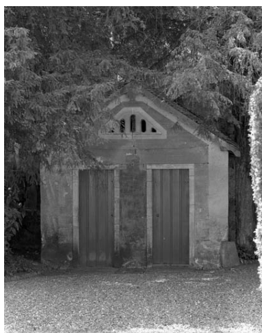
Détail des lieux d'aisance destinés au personnel. Phot. Yves Sancey IVR43_19917000370X
