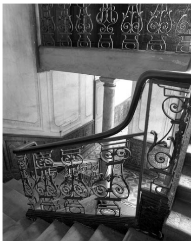
Escalier d'honneur : détail de la rampe d'escalier. Phot. Yves Sancey IVR43_19917000353X
