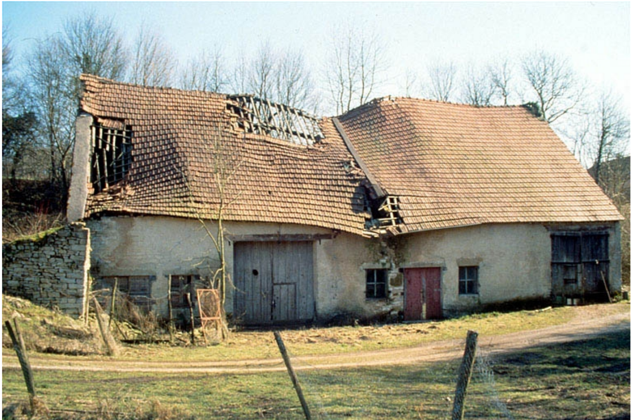
Façade antérieure de l'ancienne halle à charbon.
