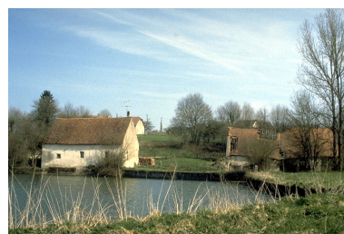
Vue d'ensemble depuis l'ouest. Phot. Laurent Poupard IVR43_19883900271ZA
