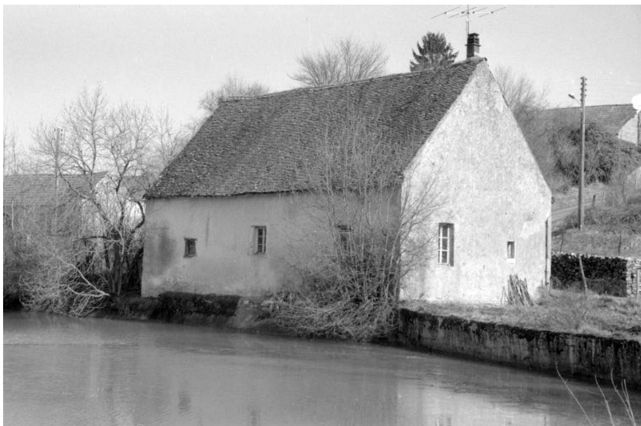
Façades postérieure et latérale gauche du logement.
