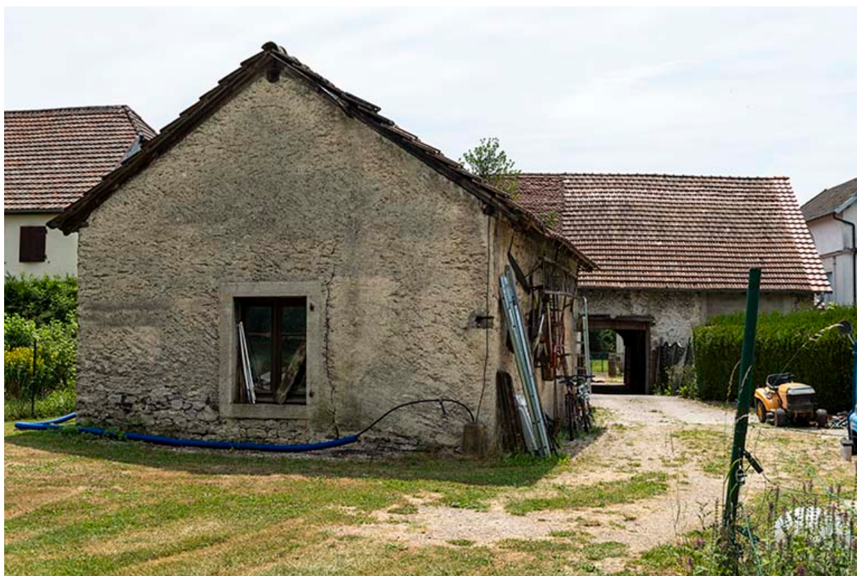
Forge : façade postérieure, de trois quarts droite.
