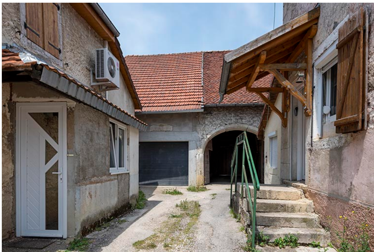
Grange, depuis l'entrée de la cour.
