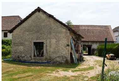
Forge : façade postérieure, de trois quarts droite. Phot. Sonia Dourlot IVR43_20192501342NUC4A
