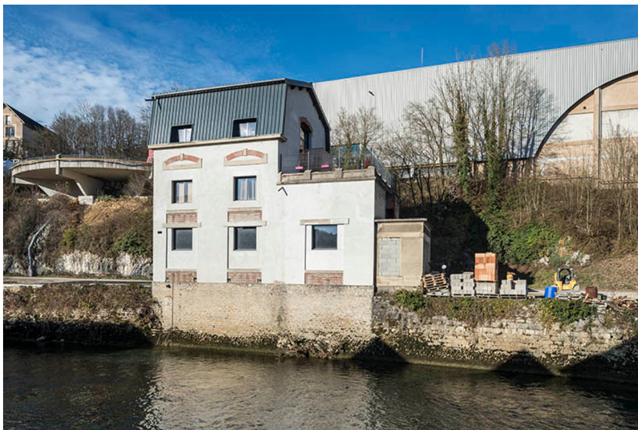
Transformateur. Façade sud.
