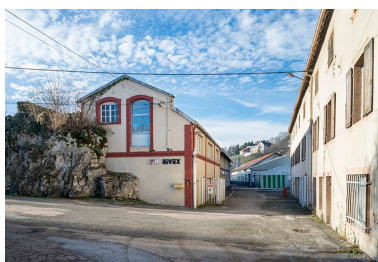
Vue d'ensemble depuis l'ancienne entrée (à l'est). Phot. Jérôme Mongreville IVR43_20162501636NUC4A
