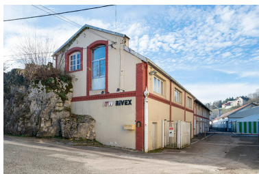
Bâtiment d'accueil de l'ancienne entrée (bureaux). Phot. Jérôme Mongreville IVR43_20162501635NUC4A
