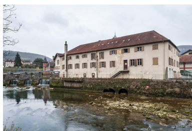
Façade nord du bâtiment du moulin. Phot. Jérôme Mongreville IVR43_20152502530NUC4A
