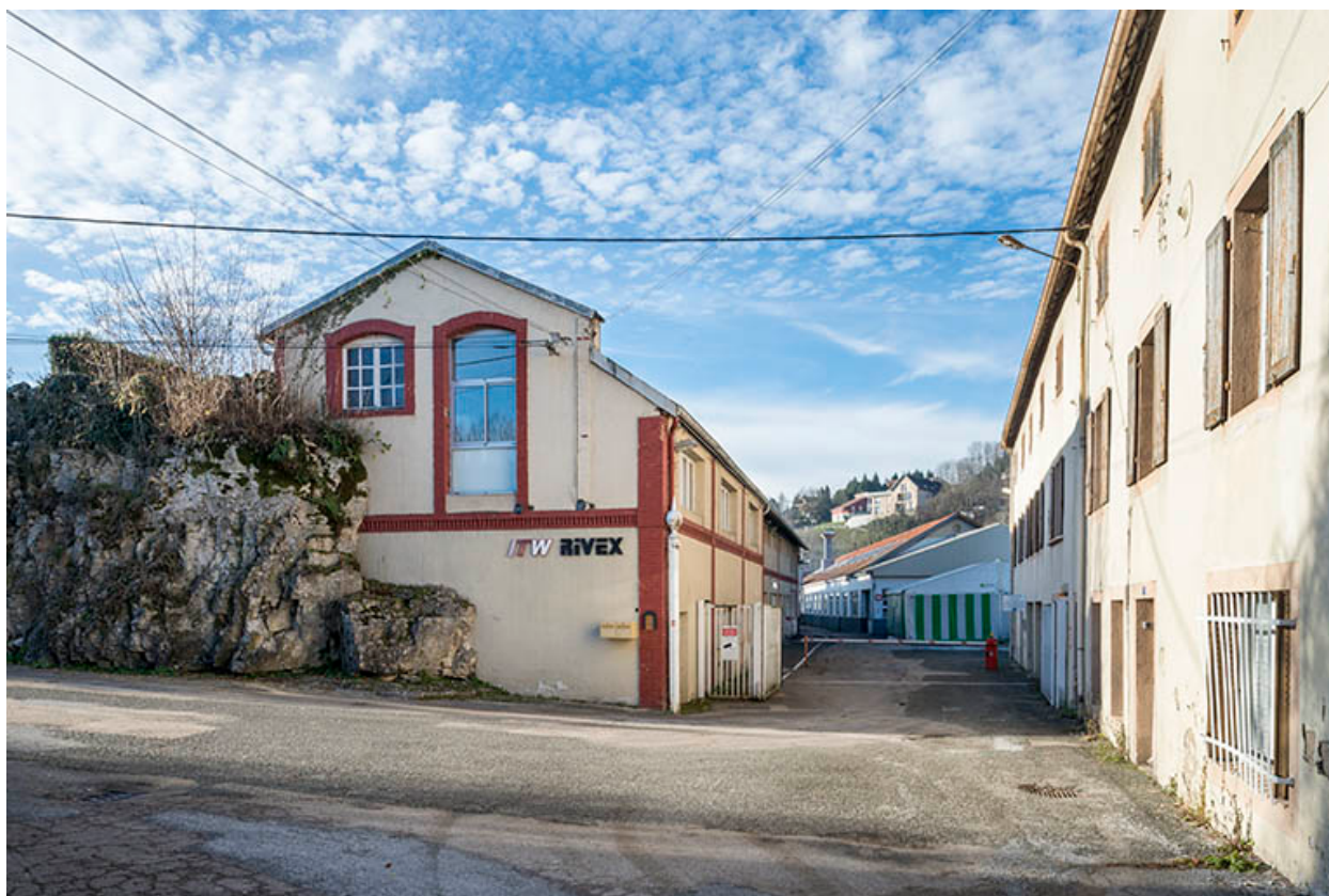
Vue d'ensemble depuis l'ancienne entrée (à l'est).
