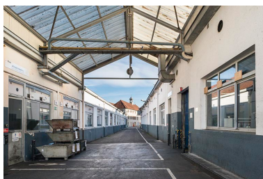
Passage couvert entre deux ateliers. Phot. Jérôme Mongreville IVR43_20162501631NUC4A
