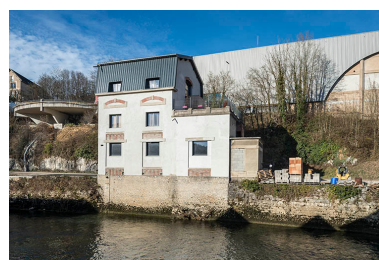
Transformateur. Façade sud.
