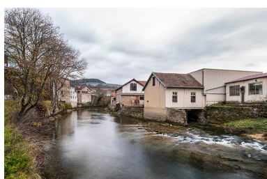
Ateliers sur la Loue, depuis l'ouest. Phot. Jérôme Mongreville IVR43_20152502535NUC4A
