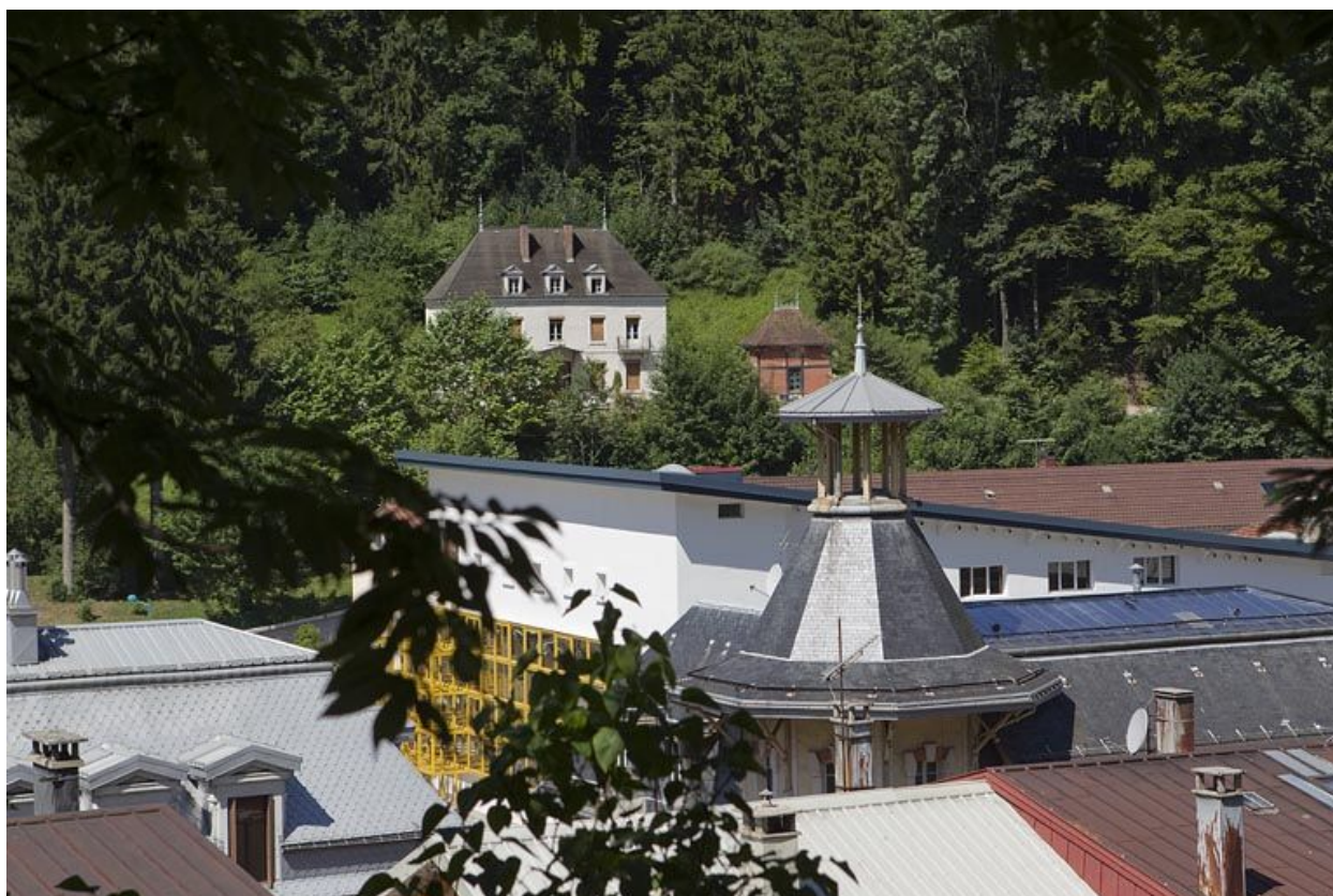
Vue d'ensemble du logement patronal.
