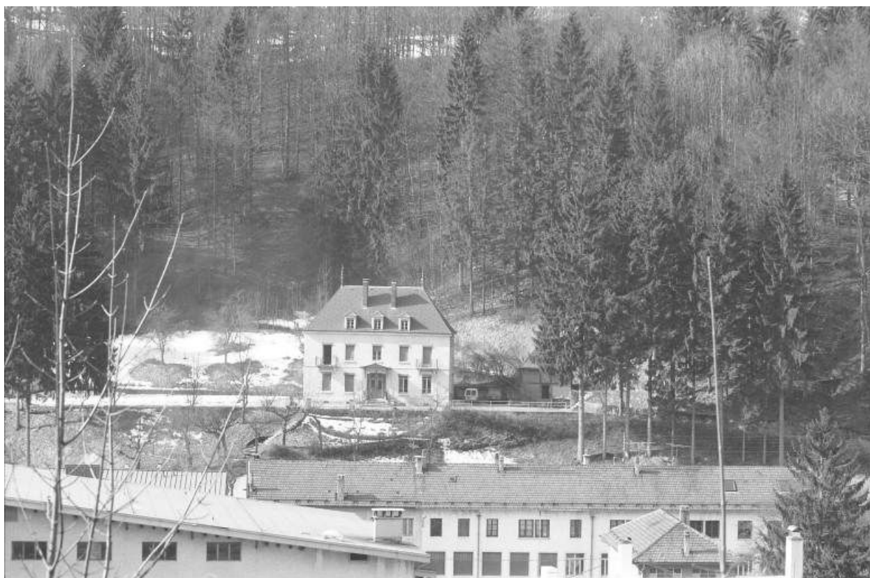
Vue d'ensemble du logement patronal.
