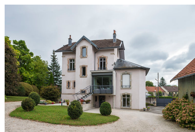
L'extension en béton. Phot. Jérôme Mongreville IVR43_20177001101NUC4A
