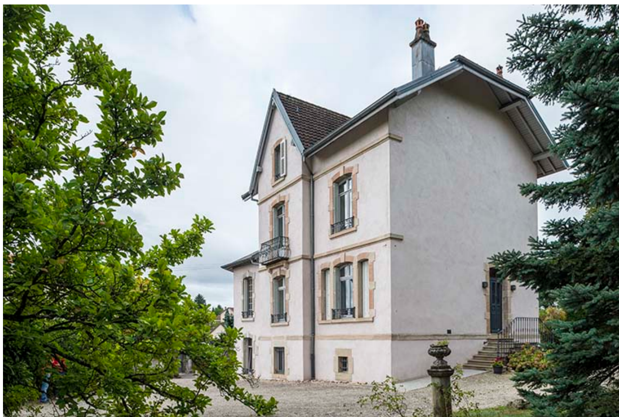
Le mur pignon nord.
