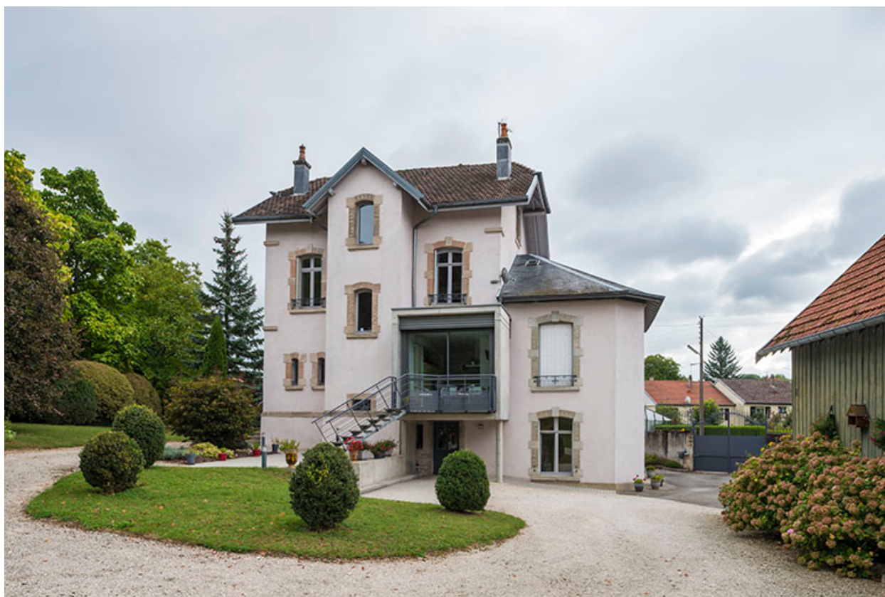
L'extension en béton.
