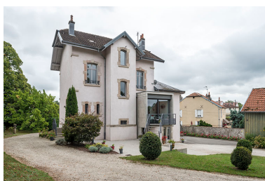
Façade postérieure. Phot. Jérôme Mongreville IVR43_20177001104NUC4A
