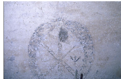
Mur nord de la 1ère travée de la nef. Phot. Yves Sancey IVR43_20022500360XA
