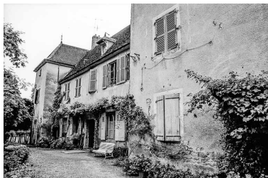
Façade antérieure vue de trois-quarts droit. Phot. Bernard Pontefract IVR43_19753900471Z
