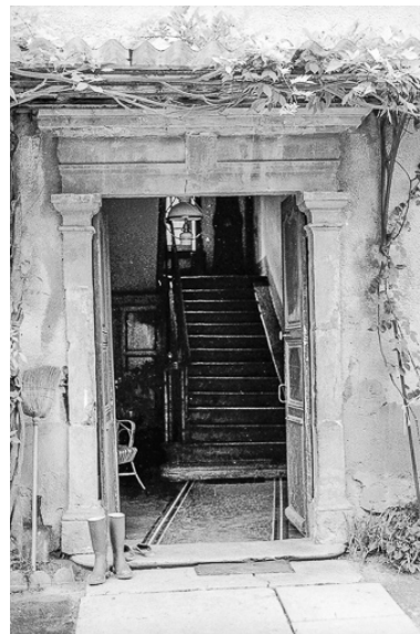
Façade antérieure : porte d'entrée. Phot. Bernard Pontefract IVR43_19753900472Z
