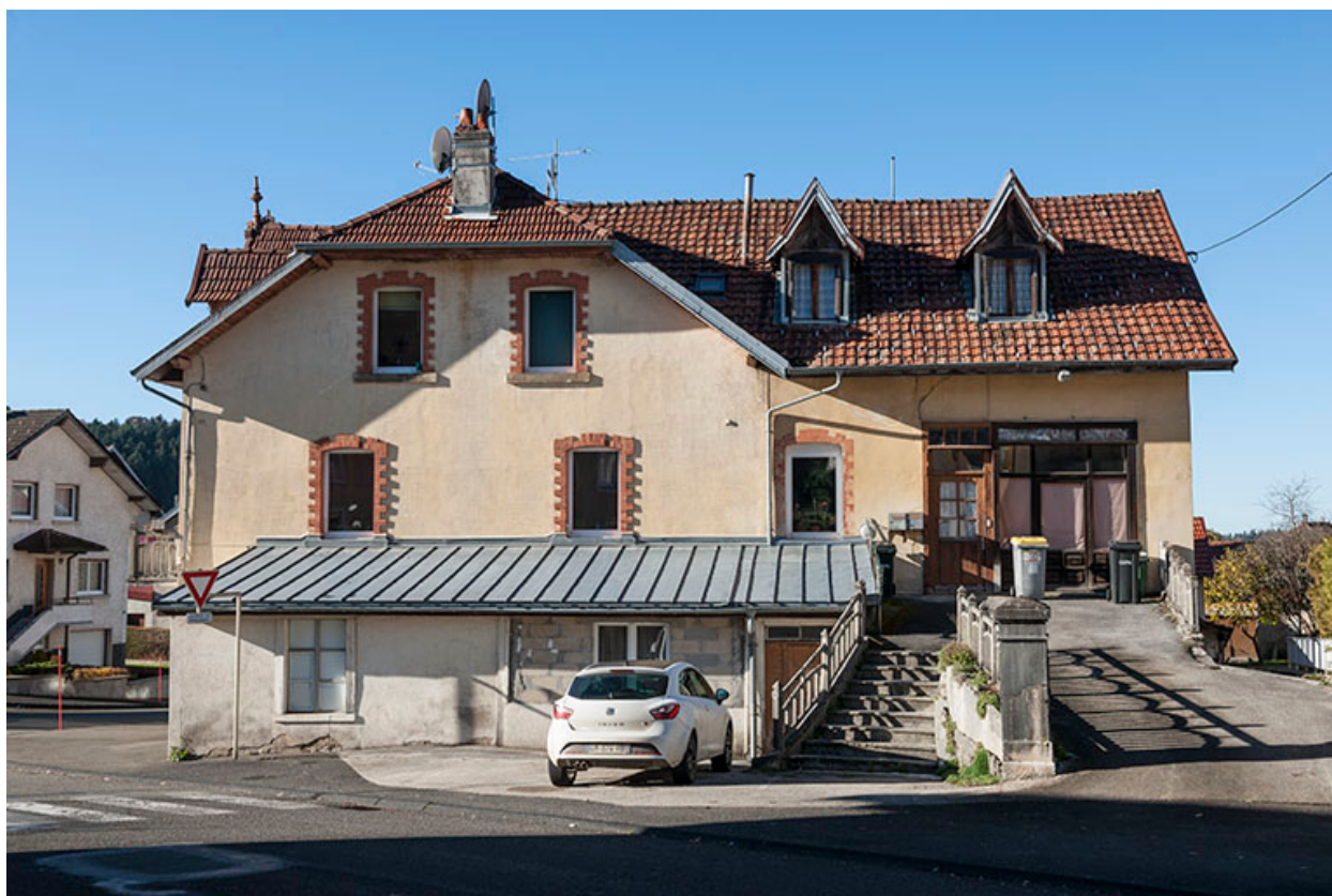
Façade latérale droite.
