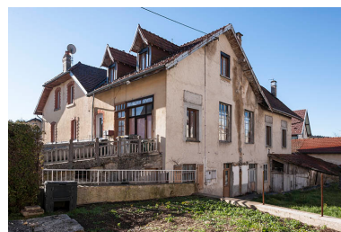
Façades postérieure et latérale droite.
