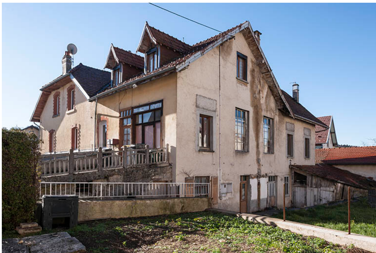
Façades postérieure et latérale droite.
