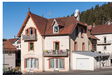
Façades antérieure et latérale droite.
