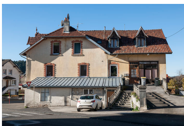
Façade latérale droite.
