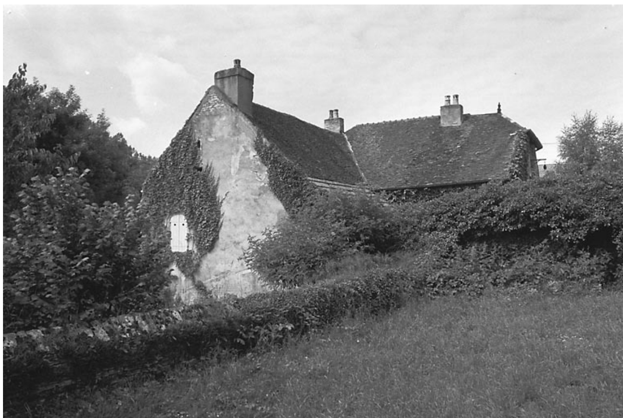
Maison située rue du Vieux Moulin.
