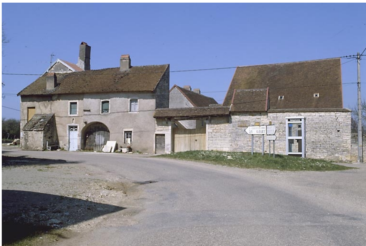
Vue d'ensemble après destruction du bâtiment agricole.
