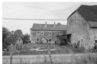
Façade postérieure sur cour. Phot. Bernard Lardière IVR43_19817000201Z
