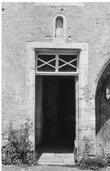
Détail de la porte d'entrée de l'habitation. Phot. Bernard Lardière IVR43_19817000206Z
