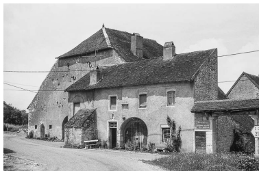
La partie habitation. Phot. Bernard Lardière IVR43_19817000204Z
