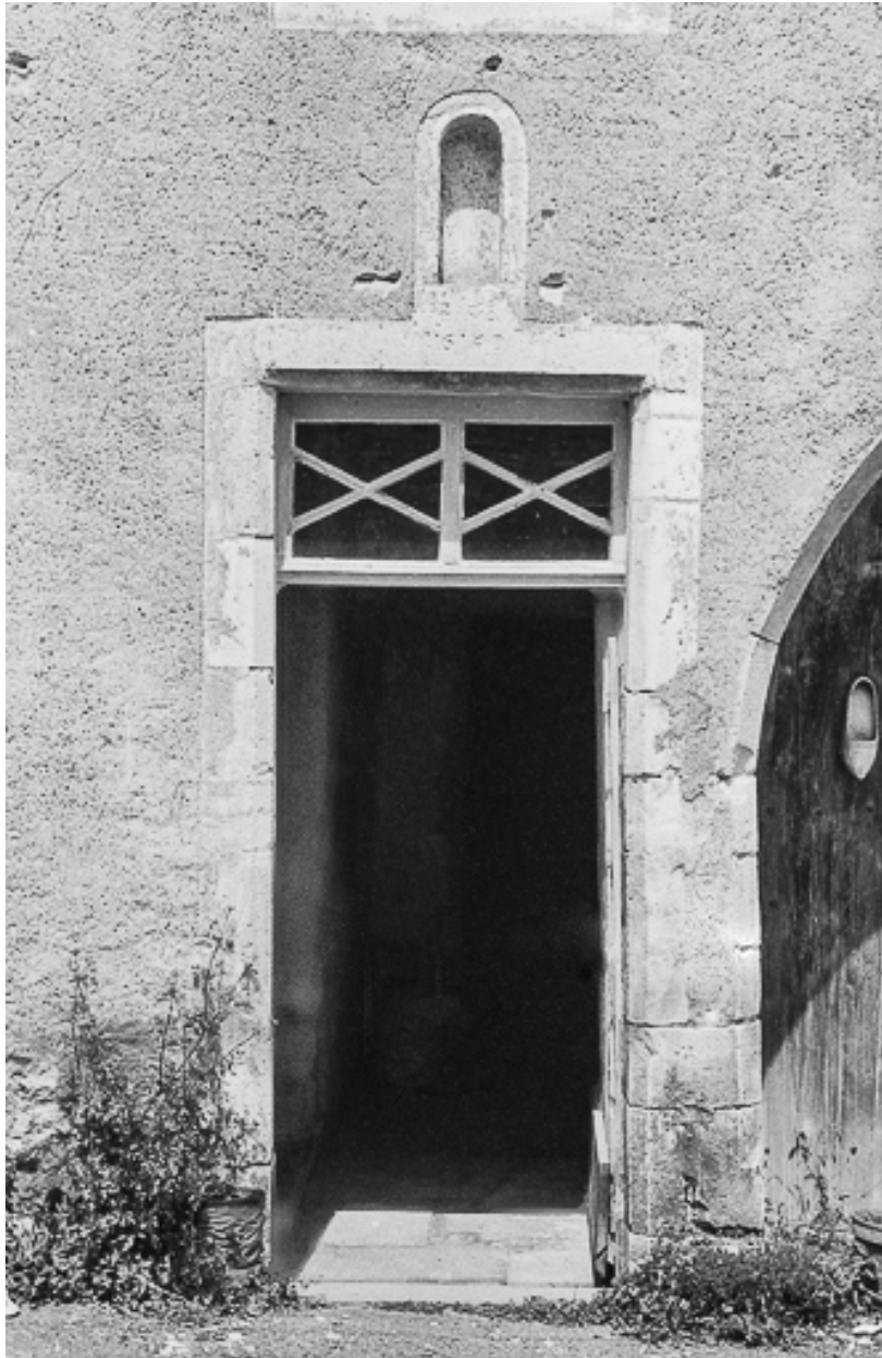
Détail de la porte d'entrée de l'habitation.
