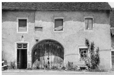
Façade principale de l'habitation. Phot. Bernard Lardière IVR43_19817000205Z
