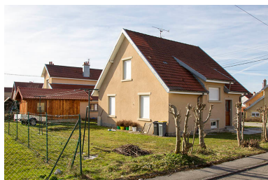
Façades latérale gauche et postérieure. Phot. Sonia Dourlot IVR43_20152500733NUC2A
