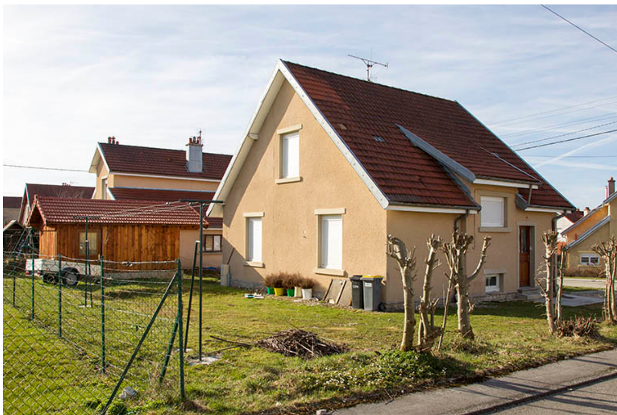
Façades latérale gauche et postérieure.
