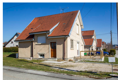
Façades latérale gauche et antérieure. Phot. Sonia Dourlot IVR43_20152500732NUC2A
