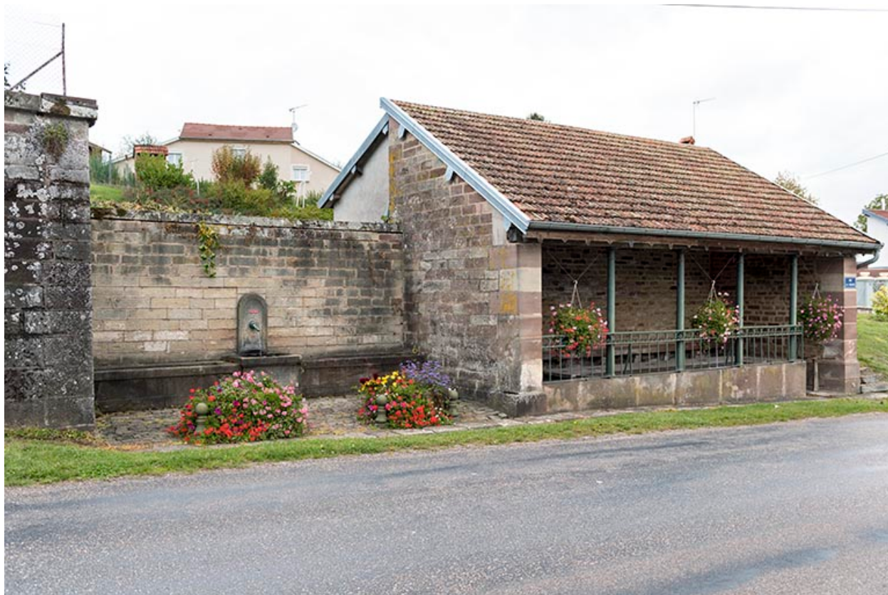
Fontaine-lavoir, rue de la Tuilerie.
