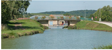
Vue du pont depuis l'amont. Phot. Pierre-Marie Barbe-Richaud IVR26_20112104032NUC4AQ
