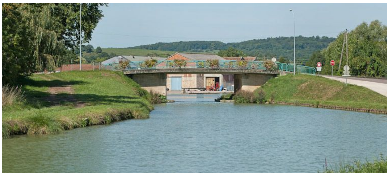
Vue du pont depuis l'amont.
