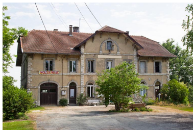
Façade antérieure. Phot. Yves Sancey IVR43_20132501264NUC2A
