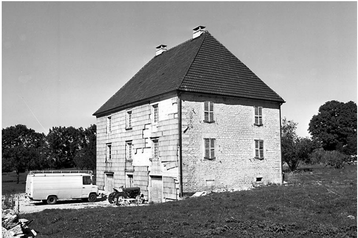
Façade antérieure et face latérale droite.
