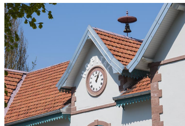
Façade antérieure. Détail du pignon. Phot. Jérôme Mongreville IVR43_20132500268NUC4A
