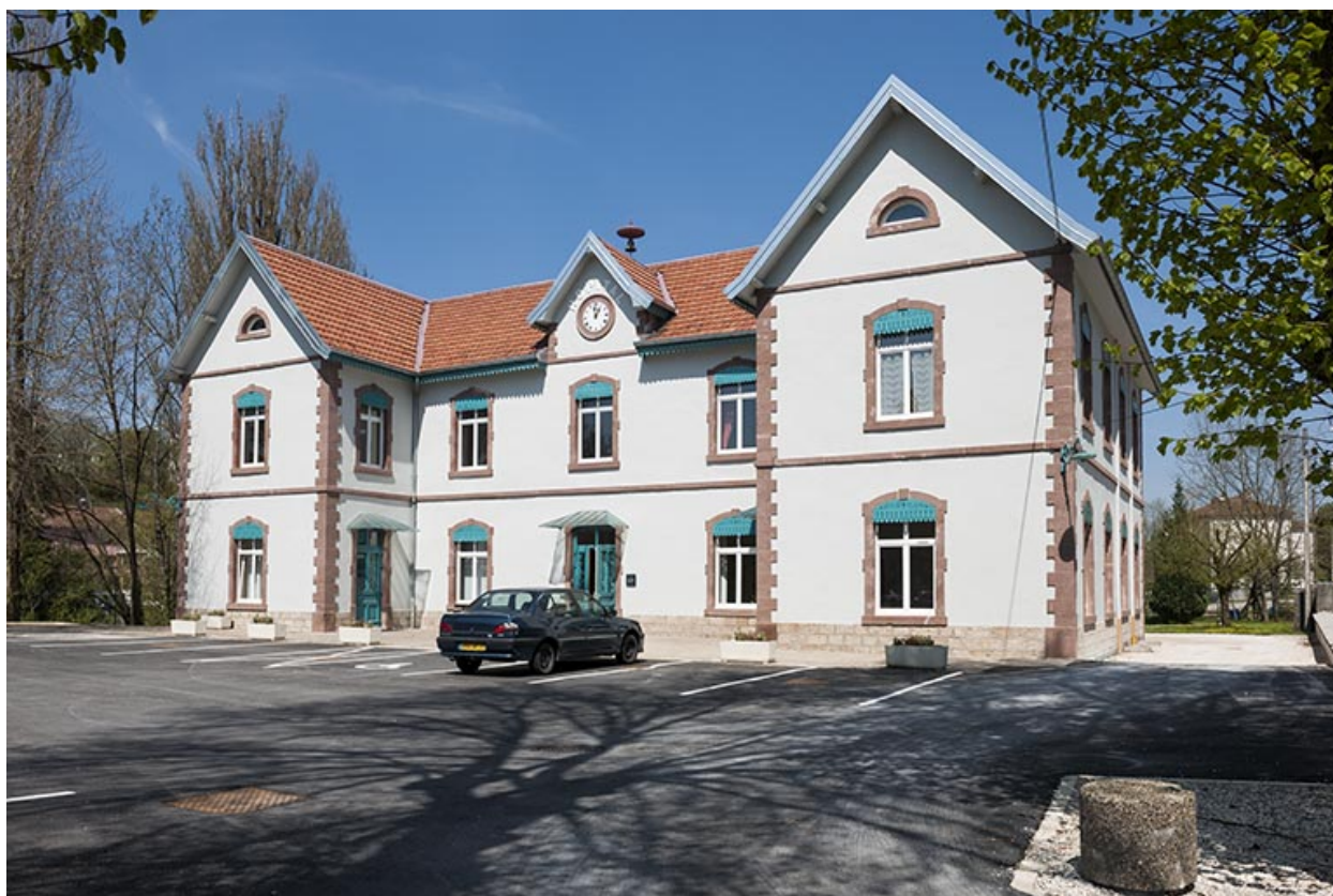
Façade sud vue de trois quarts.
